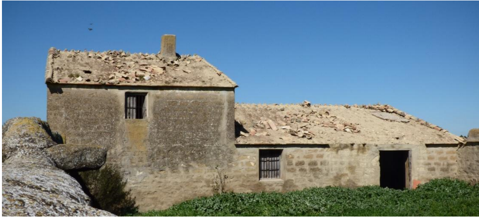
Edificaciones que forman la colonia Corral de Bernardino
