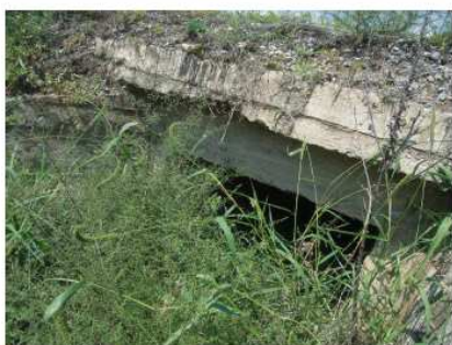
HMEPOM. 5/9/2016 Είσοδος υφιστάμενου τεχνικού στον οικισμό Καπνοχωρίου, πλάτους 1,0m, & ύψους 0,6m (βλ. Λεπτομέρεια 3 σχεδίου ZFSQ901) ΦΩΤ. 1-6 \\CRONOS\Share_T\traseis\112\ZFS\PHOTOS\2016-09-05\RIMG0027.JPG
