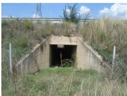
HMEPOM. 5/9/2016 ΦΩΤ. 1-14 Εξοδος τεχνικού Εγνατίας Οδού προς οικισμό Καπνοχωρίου, πλάτους 2,0m & ύψους 2,0m (βλ. Λεπτομέρεια 3 σχεδίου ZFSQ902)
