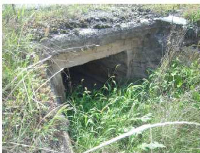
HMEPOM. 5/9/2016 Είσοδος υφιστάμενου τεχνικού στον οικισμό Καπνοχωρίου, πλάτους 1,0m, & ύψους 0,65m (βλ. Λεπτομέρεια 3 σχεδίου ZFSQ901) ΦΩΤ. 1-5 \\CRONOS\Share_T\traseis\112\ZFS\PHOTOS\2016-09-05\RIMG0026.JPG
