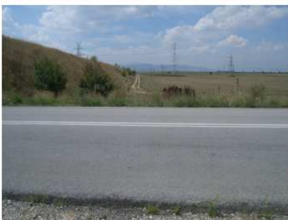
HMEPOM. 5/9/2016 Διέλευση αγωγού με διάτρηση οδού προς ΑΗΣ Αγ. Δημητρίου (βλ. Λεπτομέρεια 5 σχεδίου ZFSQ901) ΦΩΤ. 1-10 \\CRONOS\Share_T\traseis\112\ZFS\PHOTOS\2016-09-05\RIMG0042.JPG
