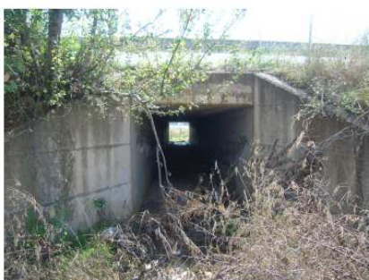
HMEPOM. 5/9/2016 ΦΩΤ. 1-13 Είσοδος τεχνικού Εγνατίας Οδού προς οικισμό Καπνοχωρίου, πλάτους 2,0m & ύψους 2,0m (βλ. Λεπτομέρεια 3 σχεδίου ZFSQ902)
