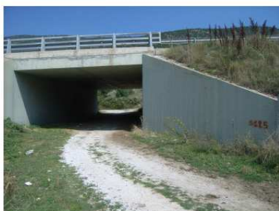
HMEPOM. 5/9/2016 ΦΩΤ. 1-10 Είσοδος γέφυρας Εγνατίας Οδού στον οικισμό Αγ. Θεοδώρων, πλάτους 8,05m, & ύψους 4,1m (βλ. Λεπτομέρεια 2 σχεδίου ZFSQ902)
