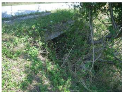
HMEPOM. 5/9/2016 Εξοδος υφιστάμενου τεχνικού στον οικισμό Λεβέντη, πλάτους 1,35m, & ύψους 1,05m (βλ. Λεπτομέρεια 1 σχεδίου ZFSQ901) ΦΩΤ. 1-2 \\CRONOS\Share_Tidraseis\112\ZFS\PHOTOS\2016-09-05\RIMG0013.JPG
