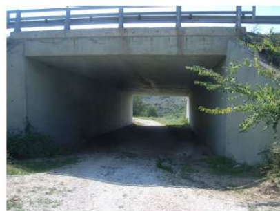
HMEPOM. 5/9/2016 ΦΩΤ. 1-12 Εξοδος γέφυρας Εγνατίας Οδού στον οικισμό Αγ. Θεοδώρων, πλάτους 8,05m, & ύψους 4,2m (βλ. Λεπτομέρεια 2 σχεδίου ZFSQ902)
