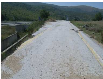
HMEPOM. 5/9/2016 ΦΩΤ. 1-9 Παλιό οδόστρωμα οδού στο δεξί έρεισμα του οποίου προτείνεται η οδευση των νέων αγωγών (βλ. Λεπτομέρεια 1 σχ. ZFSQ902)
