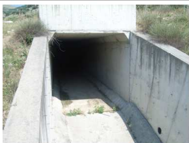
HMEPOM. 5/9/2016 Εξοδος τεχνικού Εγνατίας Οδού στον κόμβο Πολυμύλου, πλάτους 3,0m & ύψους 3,0m (βλ. Λεπτομέρεια 1 σχεδίου ZFSQ902) ΦΩΤ. 1-6 \\CRONOS\Share_Tidrasseis\112\ZFS\PHOTOS\2016-09-05\RIMG0007.JPG
