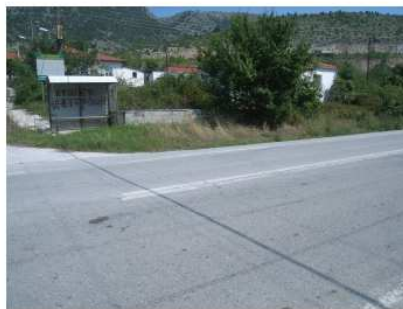
HMEPOM. 5/9/2016 Διέλευση αγωγού προς αντλιοστάσιο Αυγής με διατήρηση Εθνικής Οδού προς Αυγή (βλ. Λεπτομέρεια 2 σχεδίου ZFSQ901) ΦΩΤ. 1-3 \\CRONOS\Share_Tidraseis\112\ZFS\PHOTOS\2016-09-05\RIMG0018.JPG
