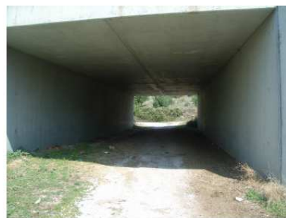
HMEPOM. 5/9/2016 ΦΩΤ. 1-11 Γέφυρα Εγνατίας Οδού στον οικισμό Αγ. Θεοδώρων (βλ. Λεπτομέρεια 2 σχεδίου ZFSQ902)
