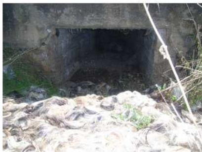
HMEPOM. 5/9/2016 Είσοδος υφιστάμενου τεχνικού στον οικισμό Λεβέντη, πλάτους 1,4m, & ύψους 1,05m (βλ. Λεπτομέρεια 1 σχεδίου ZFSQ901) ΦΩΤ. 1-1 \\CRONOS\Share_Tidraseis\112\ZFS\PHOTOS\2016-09-05\RIMG0012.JPG
