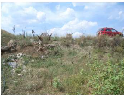
HMEPOM. 5/9/2016 Διέλευση αγωγού με διάτρηση οδού προς ΑΗΣ Αγ. Δημητρίου (βλ. Λεπτομέρεια 5 σχεδίου ZFSQ901) ΦΩΤ. 1-9 \\CRONOS\Share_T\traseis\112\ZFS\PHOTOS\2016-09-05\RIMG0040.JPG
