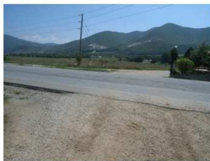
HMEPOM. 5/9/2016 Διέλευση αγωγού προς δεξαμενή Κοιλιάδας με διάτρηση Εθνικής Οδού προς Αυγή (βλ. Λεπτομέρεια 4 σχεδίου ZFSQ901) ΦΩΤ. 1-7 \\CRONOS\Share_T\traseis\112\ZFS\PHOTOS\2016-09-05\RIMG0034.JPG
