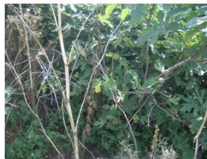
HMEPOM. 5/9/2016 Είσοδος υφιστάμενου τεχνικού προς οικισμό Γαλανίου, πλάτους 1,05m, & ύψους 0,65m (βλ. Λεπτομέρεια 6 σχεδίου ZFSQ901) ΦΩΤ. 1-12 \\CRONOS\Share_T\traseis\112\ZFS\PHOTOS\2016-09-05\RIMG0050.JPG
