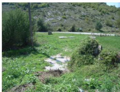
HMEPOM. 5/9/2016 Διέλευση αγωγού προς αντλιοστάσιο Αυγής με διατήρηση Εθνικής Οδού προς Αυγή (βλ. Λεπτομέρεια 2 σχεδίου ZFSQ901) ΦΩΤ. 1-4 \\CRONOS\Share_Tidraseis\112\ZFS\PHOTOS\2016-09-05\RIMG0019.JPG
