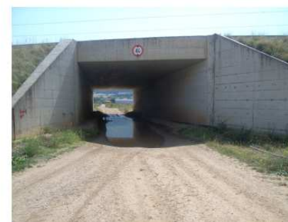
HMEPOM. 5/9/2016 ΦΩΤ. 1-15 Είσοδος γέφυρας Εγνατίας Οδού στον οικισμό Κοιλιάδας, πλάτους 7,0m, & ύψους 4,3m, με εκατέρωθεν πεζοδρόμια πλάτους 1,0m
