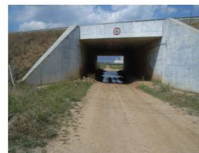
HMEPOM. 5/9/2016 ΦΩΤ. 1-16 Εξοδος γέφυρας Εγνατίας Οδού στον οικισμό Κοιλιάδας, πλάτους 7,0m, & ύψους 4,25m, με εκατέρωθεν πεζοδρόμια πλάτους 1,0m
