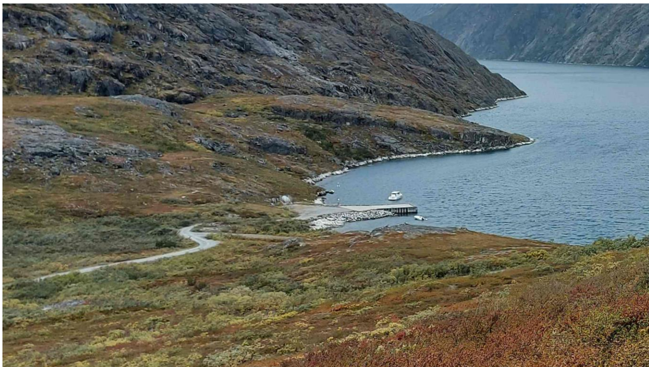
Figur 17: Foto af den eksisterende kutterkaj ved Buksefjorden
