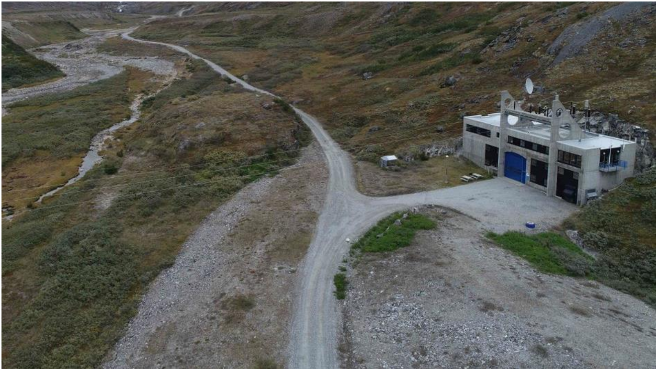
Figur 15: Foto af indgangsportalen ved den eksisterende kraftstation.
