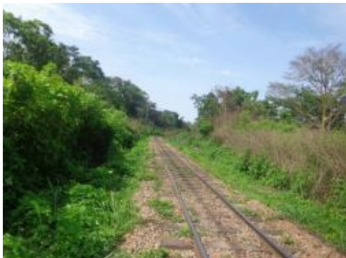
Photo 6. Voie en rails 30kg sur TB et aperçu de la végétation le long de la voie (Source groupement TEC-CUATRO/YUKSEL PROJE/INTEGC, 2021)
