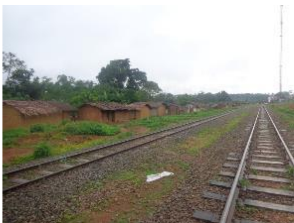
Photo 39. Habitats à proximité de la voie ferroviaire (Source : Groupement TEC-CUATRO/YUKSEL PROJE/INTEGC, Mai 2021))
