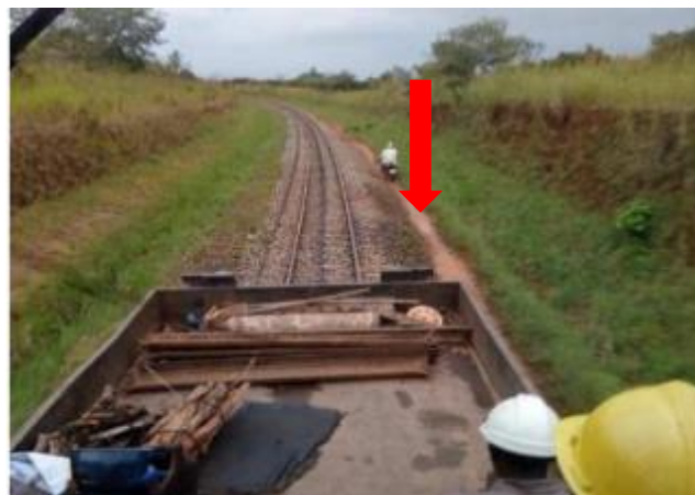
Photo 10. Accotement de la voie servant de piste de circulation aux motos, érosion de la plateforme (Source groupement TEC-CUATRO/YUKSEL PROJE/INTEGC, 2021)
