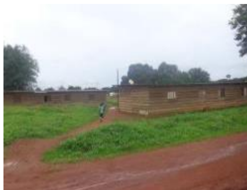
Photo 63. Maison en planche
