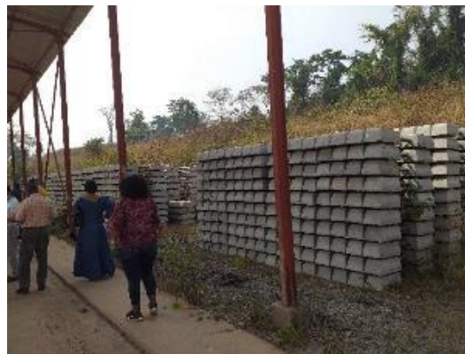
Stockage des traverses en béton bibloc préfabriquées à carrière d'Ebaka
