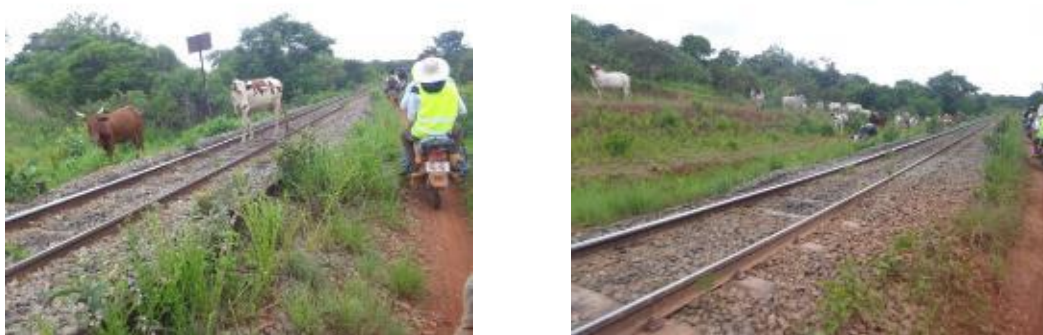
Photo 45. Présence des bœufs sur la voie ferroviaire (Source : Groupement TEC-CUATRO/YUKSEL PROJE/INTEGC, Mai 2021)
