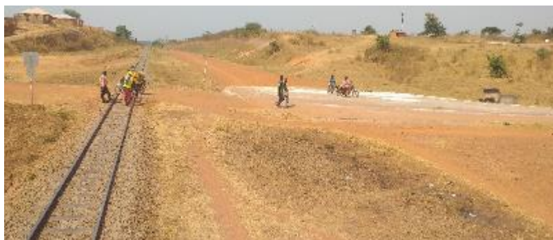
Passage à niveau au PK 664+055
