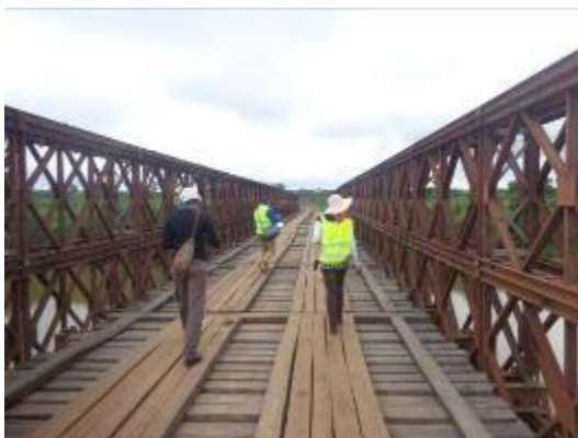
Pont métallique sur le Djérem à Djoundé
