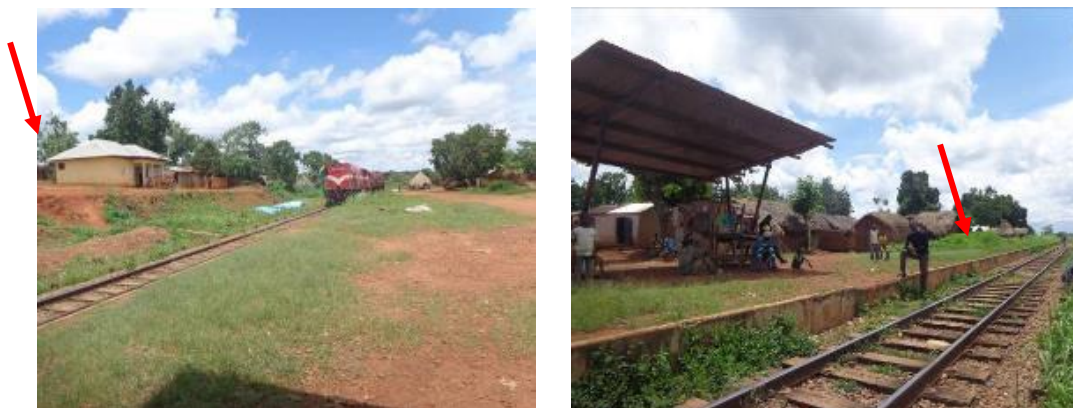
Photo 21. Habitations à proximité des rails à Maden (Source groupement TEC-CUATRO/YUKSEL PROJE/INTEGC Mai 2021)
