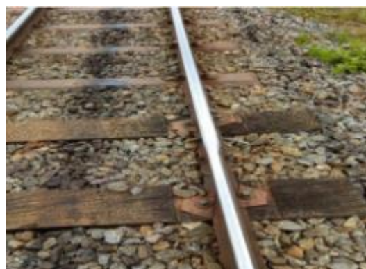
Photo 8. Voie en rails 30kg et plancher mixte bois, métal et jonction de deux rails d'usures différentes (Source groupement TEC-CUATRO/YUKSEL PROJE/INTEGC, 2021)
