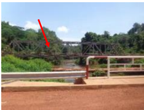
Photo 16. Pont métallique sur la Sesse à Biombe
