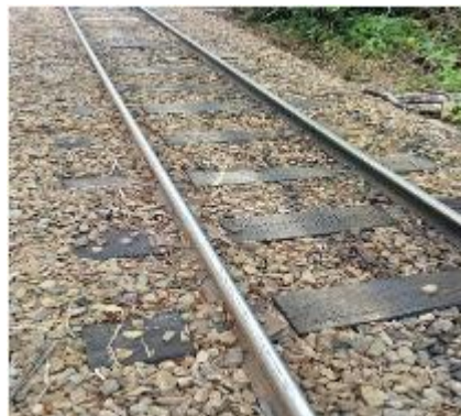
Photo 6. Voie en rails 30kg sur TB et aperçu de la végétation le long de la voie (Source groupement TEC-CUATRO/YUKSEL PROJE/INTEGC, 2021)
