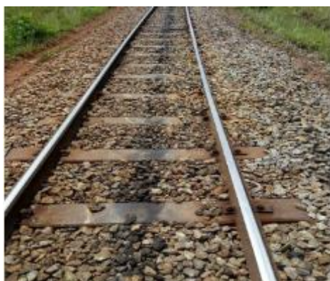
Photo 7. Voie en rails 30kg sur TM (Source groupement TEC-CUATRO/YUKSEL PROJE/INTEGC, 2021)
