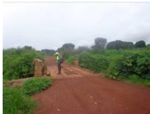
Pont en bois sur le Pangara à Ngaoundal
