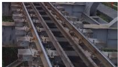
Traverse en bois : Il s'agit ici d'une voie sur traverses bois posées sur un pont métallique.
