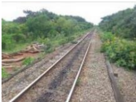
Photo 29. Déversement des hydrocarbures sur les rails à Maloua
