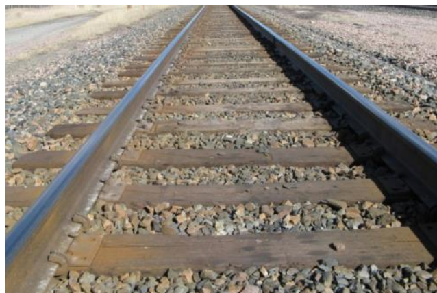
Figure 1: Utilisation du bois créosoté comme traverses de chemin de fer
