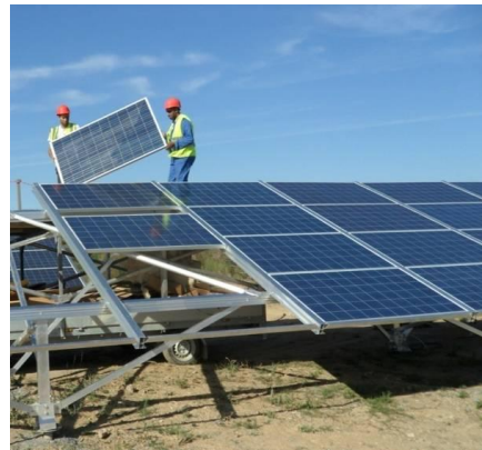
Figure 9: mise en place des panneaux sur les structures
