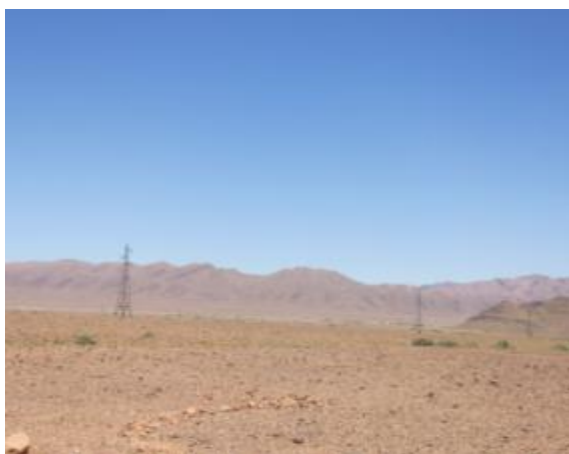
Photographie 11: Lignes électriques existantes au voisinage du site du projet
