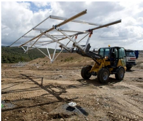
Figure 8: Exemple de montage des structures
