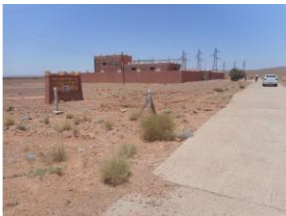
Figure 41: Poste de livraison 22/60KV de Bouanane et sa piste d'accès
