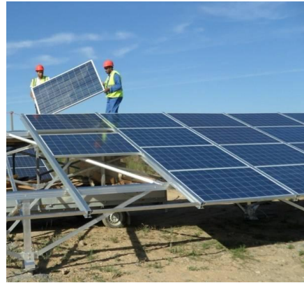
Figure 11: mise en place des panneaux sur les structures
