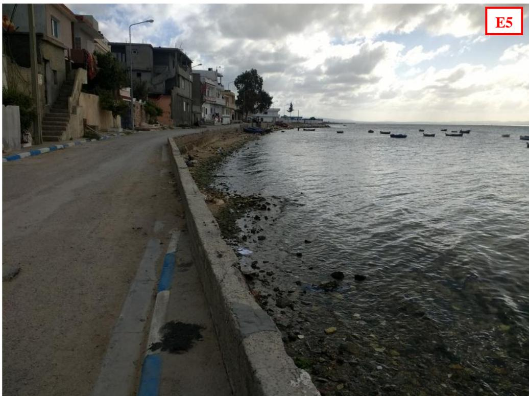
**Photo 10 : Mur vertical avec protection en enrochements au pied du mur**
