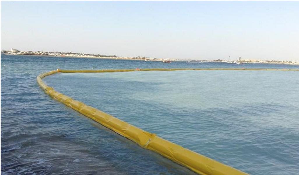
Figure 52 : Schéma d'un écran anti-turbidité
