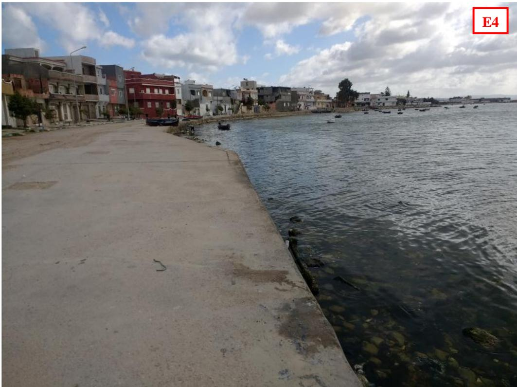
**Photo 9 : Anse à l'Est du port (350 ml) : Mur vertical et protection en enrochements**
