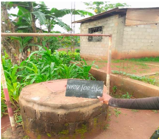
Puit aménagé à Nkozoa
