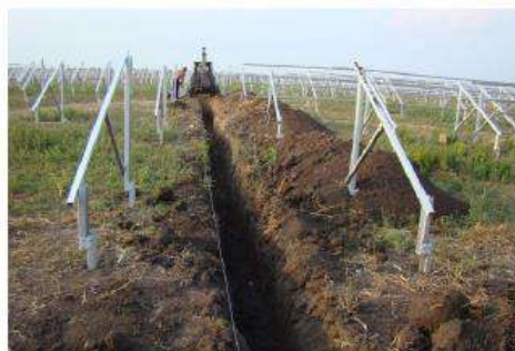
Figura núm. 24. Estesa de cable en rasa i estructura metàl·lica de suport.
