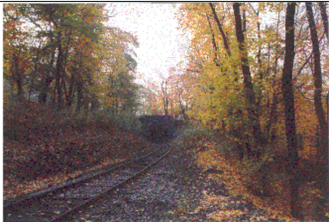
Vstup do východního portálu tunelu ve Stromovce
