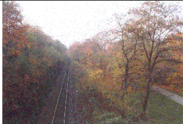
Pohled z mostu pod Kamenickou na trať k tunelu
