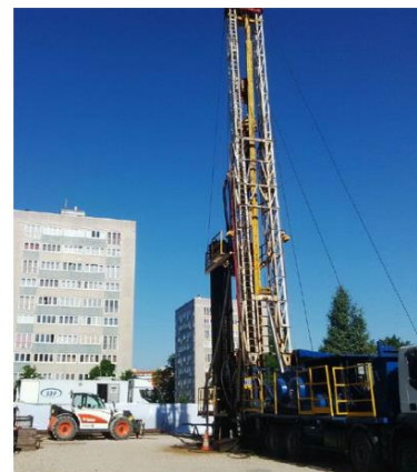
Figure 157 : photographie de maintenance exceptionnelle sur les puits en zone urbaine
