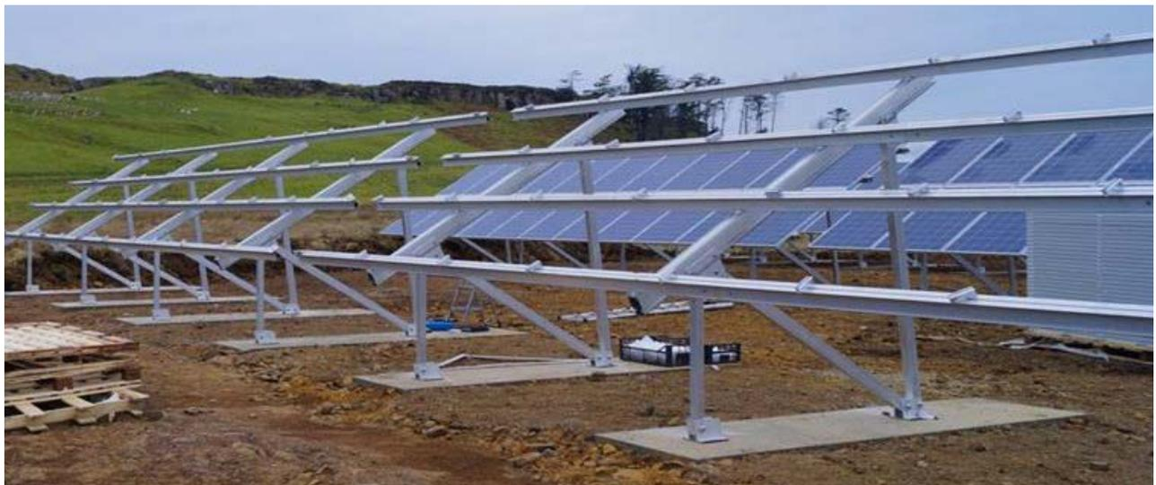
Figure 8 : Table de panneaux photovoltaïques en construction
