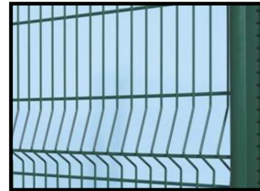
**Figure 42 : Exemple de clôture à mailles rectangulaires, présentant un resserrement des mailles en partie haute (200x50 mm en partie centrale, rétrécie en 100x50 mm en partie haute).**
