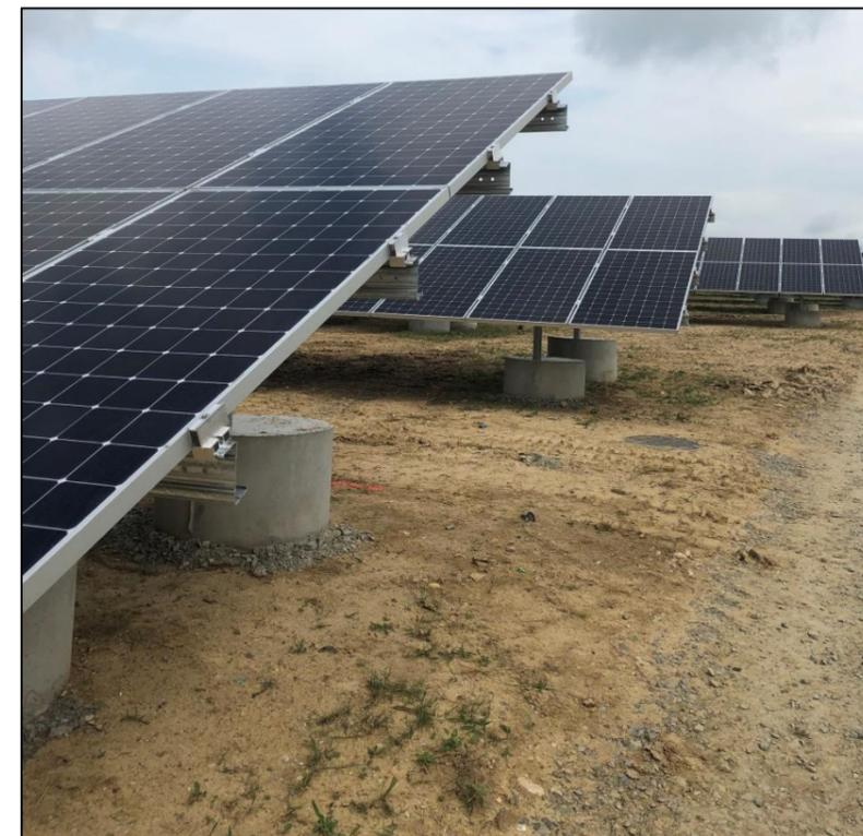
Figure 24 : Structures lestées par pieux hybrides – ferme solaire de Machecoul, une réalisation IEL
