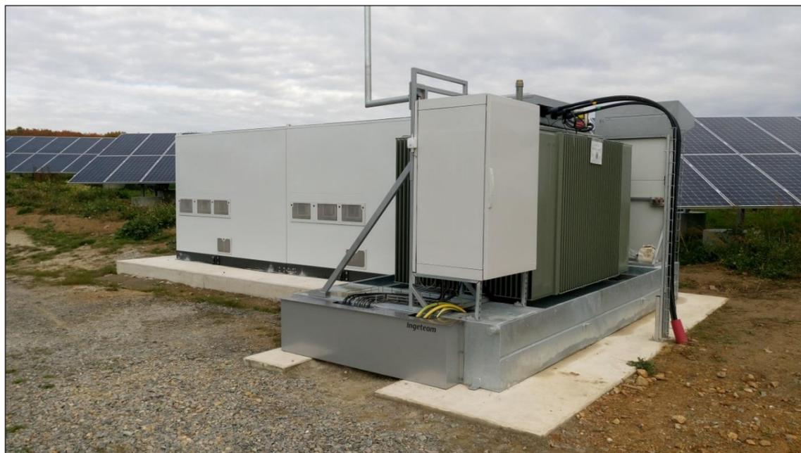
Figure 32 : Exemple d'un poste électrique outdoor mis en place sur la centrale photovoltaïque de Machecoul (44), une réalisation IEL
