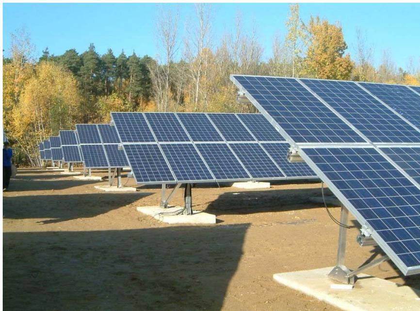
ARMORGREEN, adossé au groupe LEGENDRE, expert en BTP propose de réaliser les semelles béton en interne *via* l'entreprise OuestPréfa basée à Bourbarré (35) et appartenant à la holding LEGENDRE. La fabrication des semelles est envisagée directement sur le site afin de limiter l'impact du transport.
