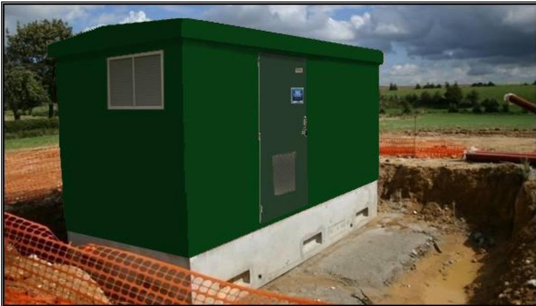
**Figure 6 : Local préfabriqué standard**
