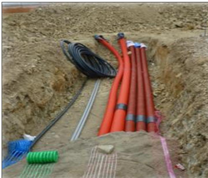
**Figure 7 : Câblage sur site, hors des zones de déchets, entre les panneaux photovoltaïques et les postes électriques et entre les postes électriques et le poste de livraison**
