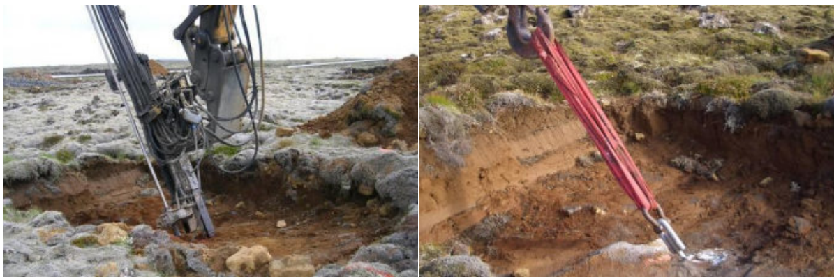
Mynd 3.8. Til vinstri sér hvar borað er fyrir bergbolta og myndin til hægri sýnir bergboltaprófun.
