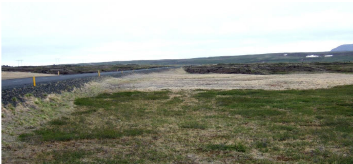
Mynd 12.2. Þverun hverfisverndarsvæðisins, 350-Hv Búrfellshraun í Skútustaðahreppi. Lengst til vinstri sést hvar Kröflulína 2 fer yfir hrauntunguna. Línustæði Kröflulínu 3 er norðan Kröflulínu 2.
