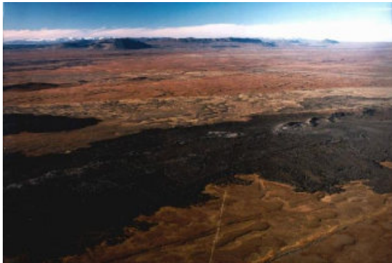
Kröflulína 3 þverar Nýjahraun við hlið Kröflulínu 2.
