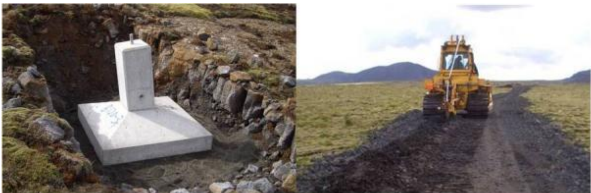
Mynd 3.7. Til vinstri má sjá forsteypta undirstöðu M-masturs og hægri sést hvernig jarðskaut er plægt í kant á vegslóð.
