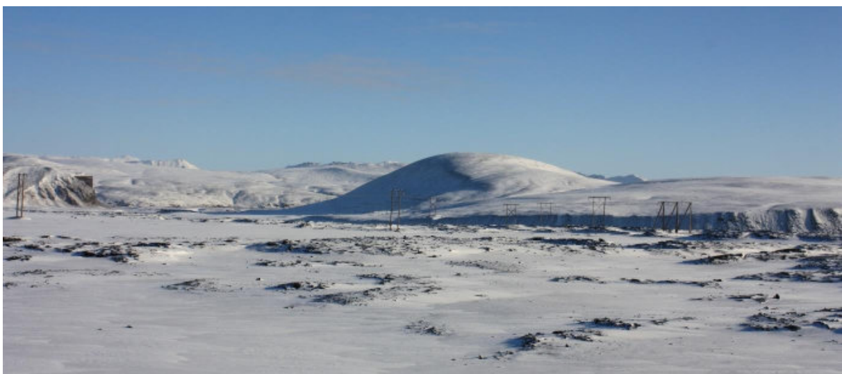
Mynd 11.15. Horft til austurs að þverun Kröflulínu 2 á Jökulsá á Fjöllum.
