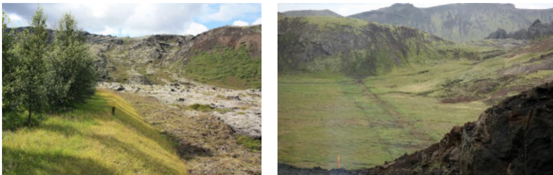
Mynd 6.2. Frágangur eftir jarðstrengi er misauðveldur eftir aðstæðum. Báðar myndirnar eru af strengskurði eftir frágang við lagningu Nesjavallalínu 2.
