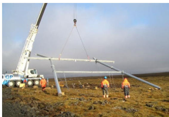
Mynd 3.9. Myndir sýna vinnu við samsetningu og reisingu stagaðs burðarmasturs af M-gerð. Myndirnar eru frá byggingu Reykjaneslínu 1.
