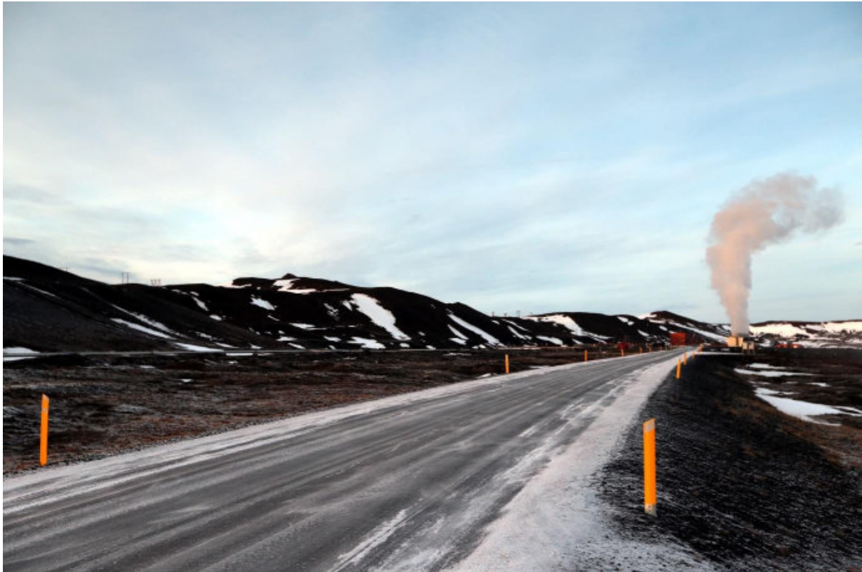
Mynd 10.5. Horft af Kröfluvegi upp að Kröflustöð. Vegurinn liggur í gegnum hraun frá Daleldum sem valkostur B1 og aðalvalkostur þvera.
