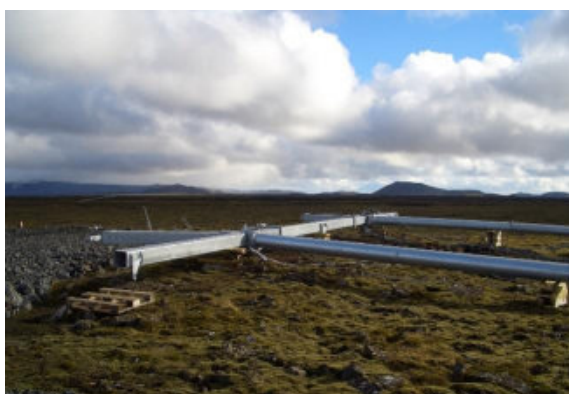
Mynd 3.9. Myndir sýna vinnu við samsetningu og reisingu stagaðs burðarmasturs af M-gerð. Myndirnar eru frá byggingu Reykjaneslínu 1.
