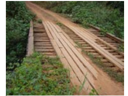
Platelage en bois d'un pont
