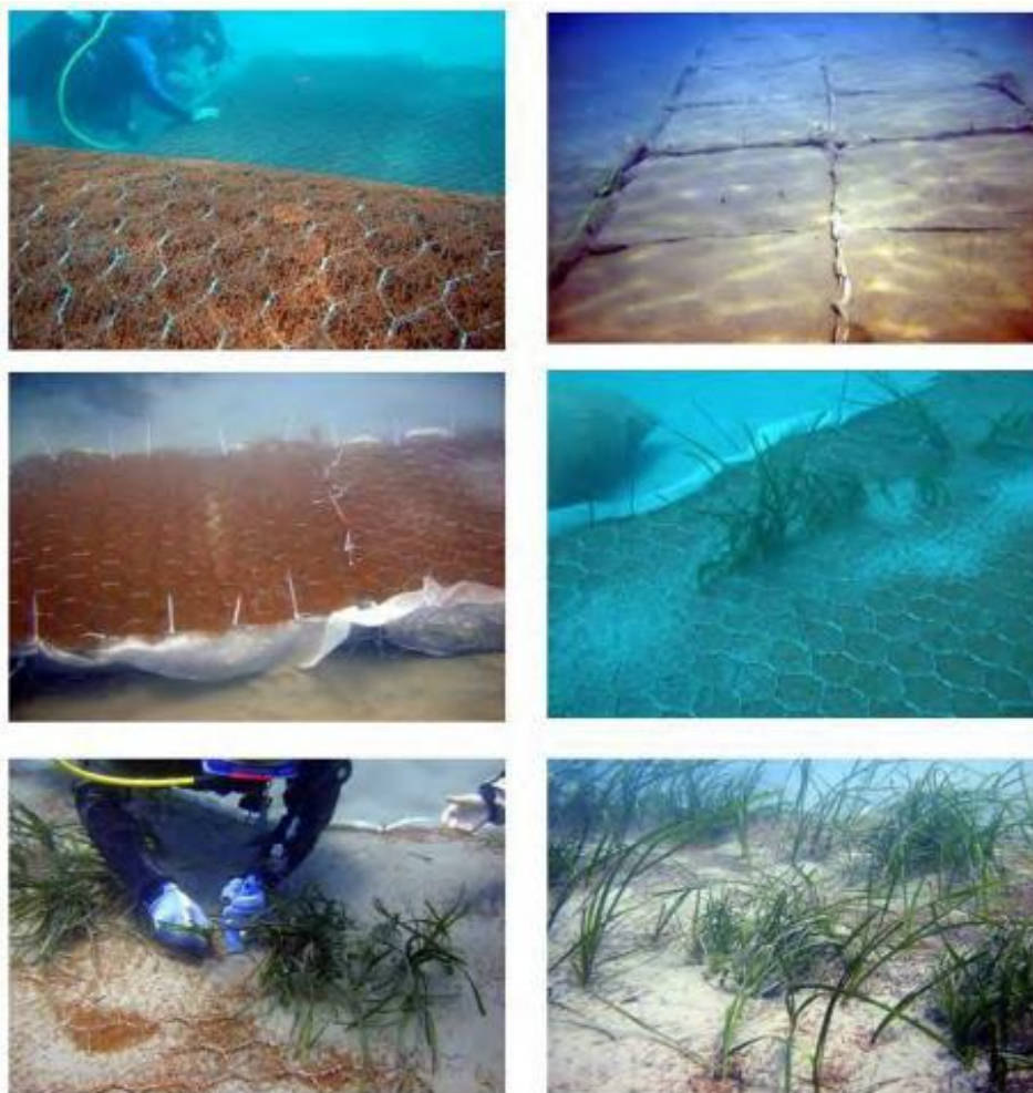
Figura 62: trapianto con materassi rivegetati - sequenza di fasi operativi (estratto da Linee Guida 106/2014 ISPRA – pagg. 67-68)
