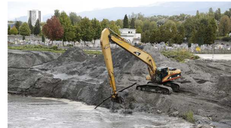
Photo 3 : Excavation de la berge sur l'Isère (source lametro.fr)
