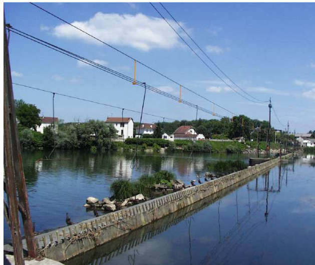
Photo 4 : Barrage d'Auxonne sur la Saône, et son dispositif de transport des aiguilles (Source : CETE Lyon).
