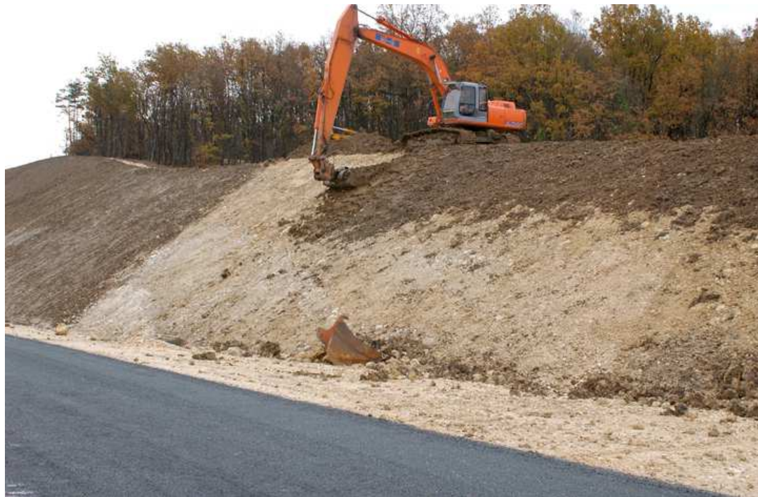
Photo 2 : Mise en place de terres végétales sur un dépôt de 1 M de m 3 (Source : Setec)
