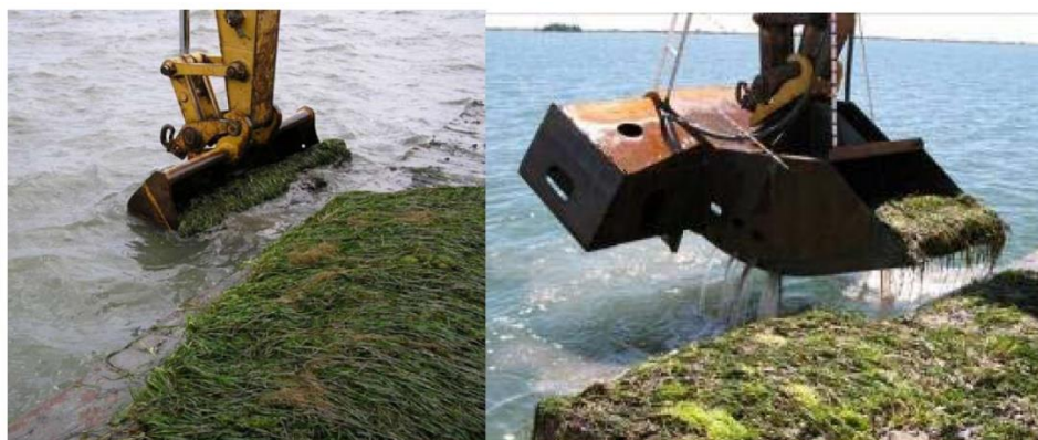
Figura 6: Fase di prelievo di grandi zolla mediante mezzi meccanici, con benna tradizionale (a sinistra) e con benna idraulica (a destra) recentemente messa a punto che permette di realizzare lo scavo per alloggiamento delle zolle contestualmente alla posa.
