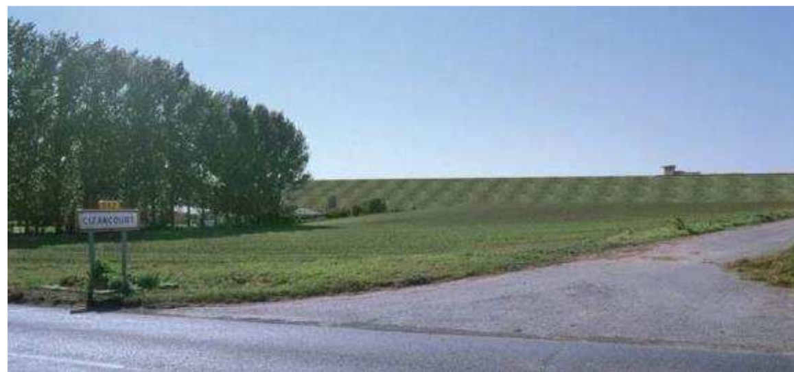
Figure 46 : Vue du projet à Cizancourt le canal franchit un vallon avec un remblai important (environ 20 mètres de haut).
