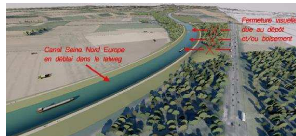
Figure 50 : Vue du CSNE reprenant le Canal du Nord au droit d'Havrincourt (Source : APSM AREP)
