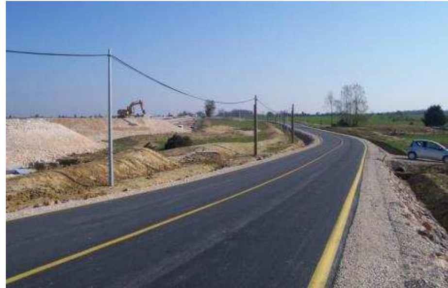
Photo 7 : Mise en place dérivation de route (Source : chantier LGV Rhin-Rhône, setec)
