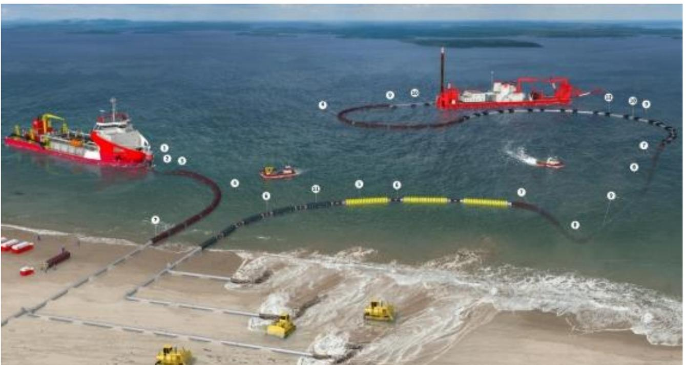
Figura 4.35 - Operazioni di refluento idraulico (Royal IHC, 2018)
