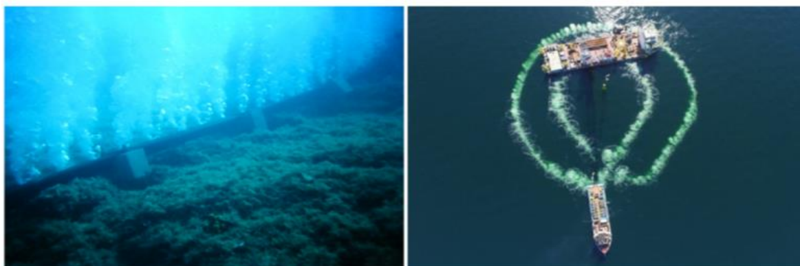
Figura 3.17: Zone con cortina di bolle rilasciata da un tubo perforato poggiato sul fondo (sinistra) e doppia cortina di bolle utilizzata intorno ad una imbarcazione (a destra) (© hydrotechnik lübeck gmbh) https://www.offnoise-solutions.com/the-hydro-sound-damper-system-hsd-system/
