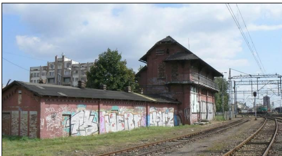
Fot. 11.2 Budynek nastawni i magazyn na ul. Sądowej przeznaczony do rozbiórki [33]
