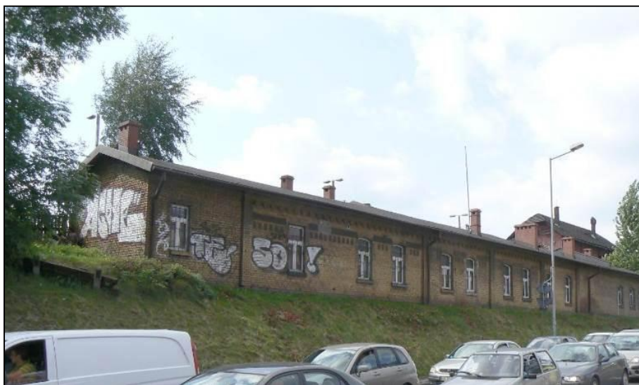
Fot. 11.1 Budynek magazynu na ul. Sądowej przeznaczony do rozbiórki [33]
