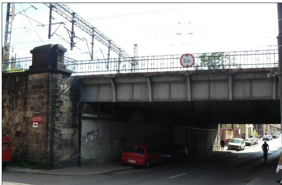
Fot. 11.4 Wiadukt kolejowy nad ul. Damrota (w km ok. 317+372 / 31+969) przeznaczony do rozbiórki [33]
