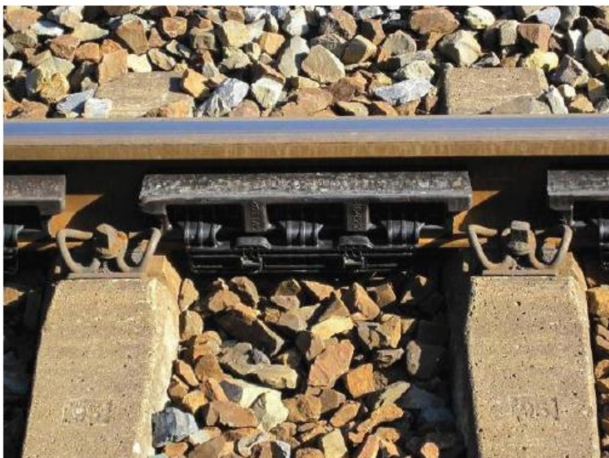
Rys. 8.11 Inny przykład tłumika torowego (wg DB Netz AG, Schmidt: Innovative Maßnahmen zum Lärm- Und Erschütterungsschutz am Fahrweg. Schkussbericht. DB Netze. 15.06.2012 )
