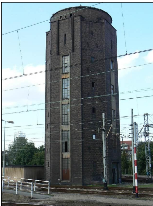
Fot. 11.3 Wieża ciśnień przeznaczona do przebudowy [33]
