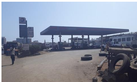
Station total dans la zone mitoyenne
