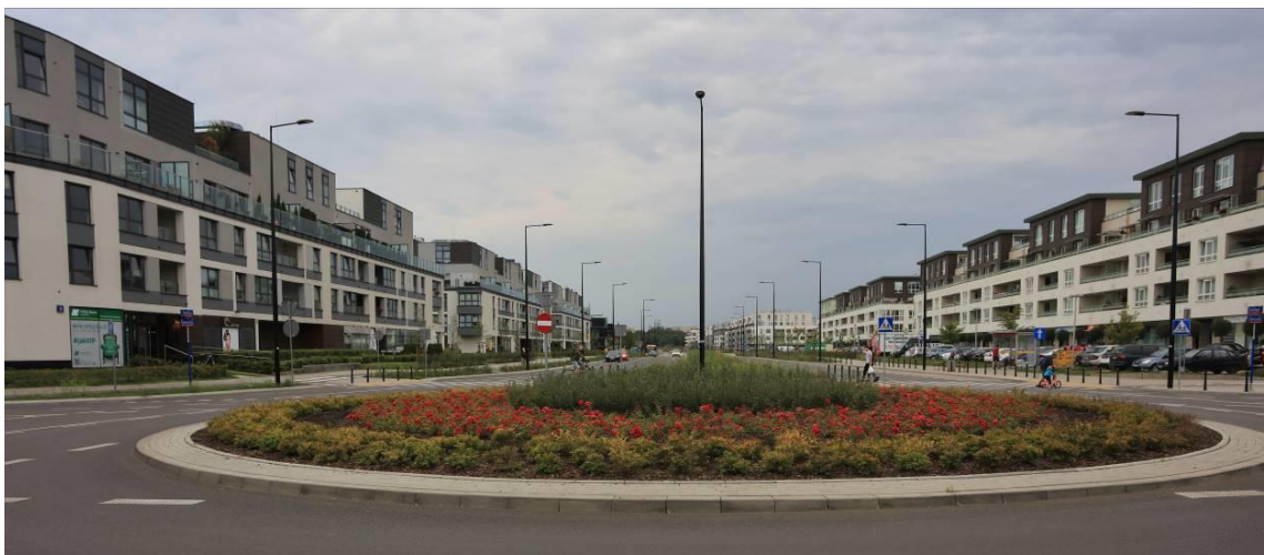
Fotografia 12. Pas zieleni rozdzielający jezdnie ul. Branickiego, wzdłuż której prowadzi odnoga linii tramwajowej w kierunku ul. Przyczółkowej (wariant wskazany przez Inwestora).
