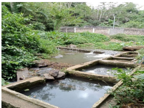
Figura 6 Nascente de Água Amoreira 1
