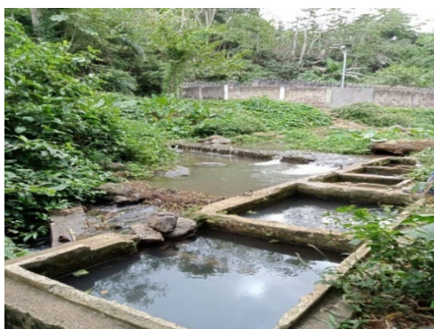
Figura 6 Nascente de Água Amoreira 1
