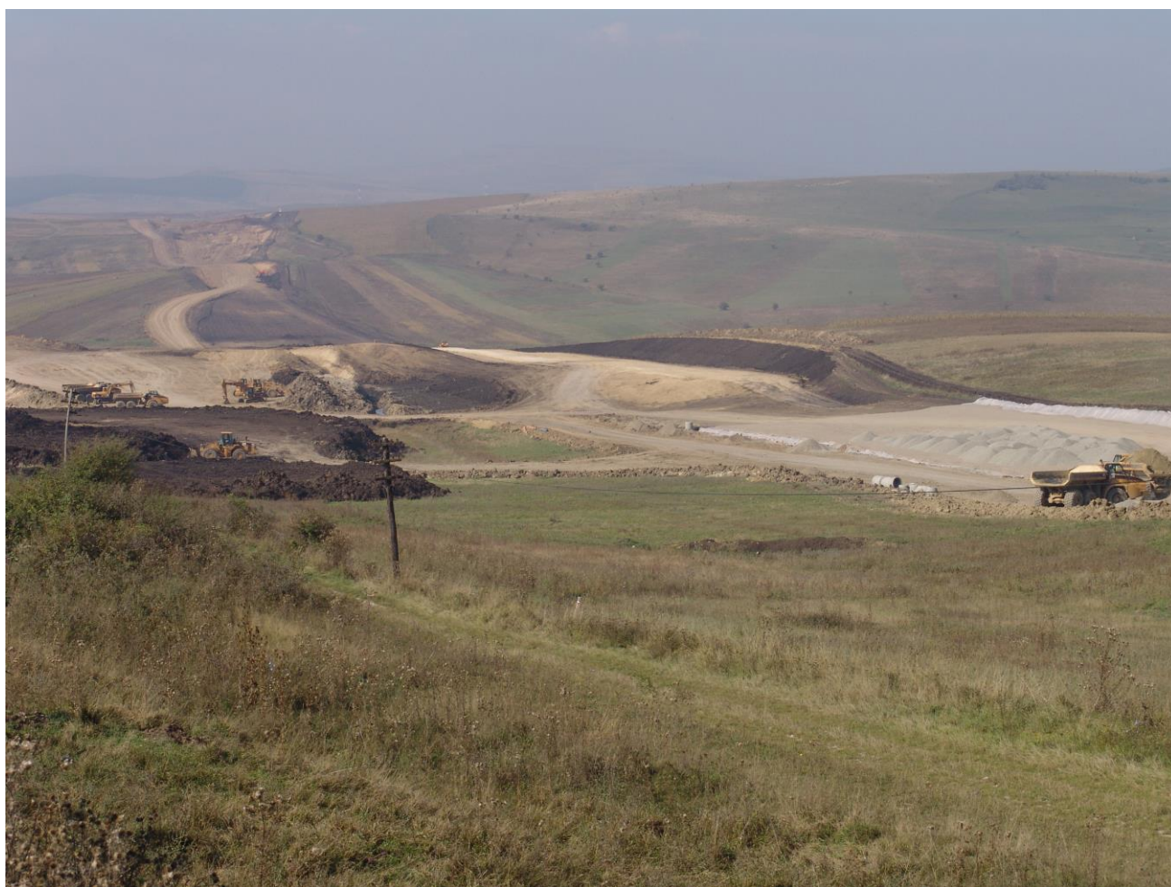
Fig.5.I.Şantierul desfăşurat la nivelul sectorului 2B Câmpia Turzii – Gilău, anul 2006 Se observă desfăşurarea lucrărilor pe o lăţime de aproximativ 100m faţă de ax
