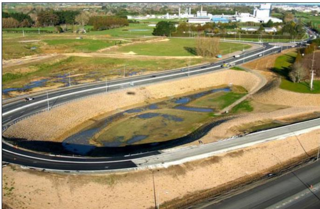
Fig.4.II.Bazin decantor de la nivelul unei bretele de autostradă [Chalmers Univ. of Tech. 17 ]
