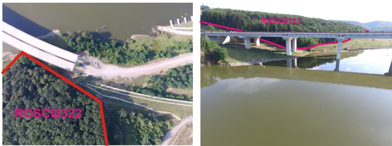
Fig.2.XVIII.Zona de suprapunere a viaductului autostrăzii cu ROSCI0322 – se observă absența impactului direct
