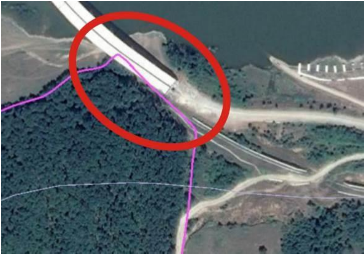
Fig.3.I.Zona de suprapunere a proiectului cu ROSCI0322 (linie roz) – se observă pre-existentă unor elemente constructive majore asociate proiectului (viaduct, terasamente, etc.) dar și absența unor habitate în măsură a întruni exigentele ecologice ale elementelor criteriu ce au stat la baza desemnării sitului. În plus se mai observă că cea mai mare parte a elementelor constructive ale autostrăzii au fost realizate în etapele anterioare, rămânând doar unele lucrări punctuale (asfaltare, racordarea la sectoarele următoare, etc.) pe un traseu suspendat, impactul asociat fragmentării fiind astfel anulat [prelucrat după GoogleEarth™]
