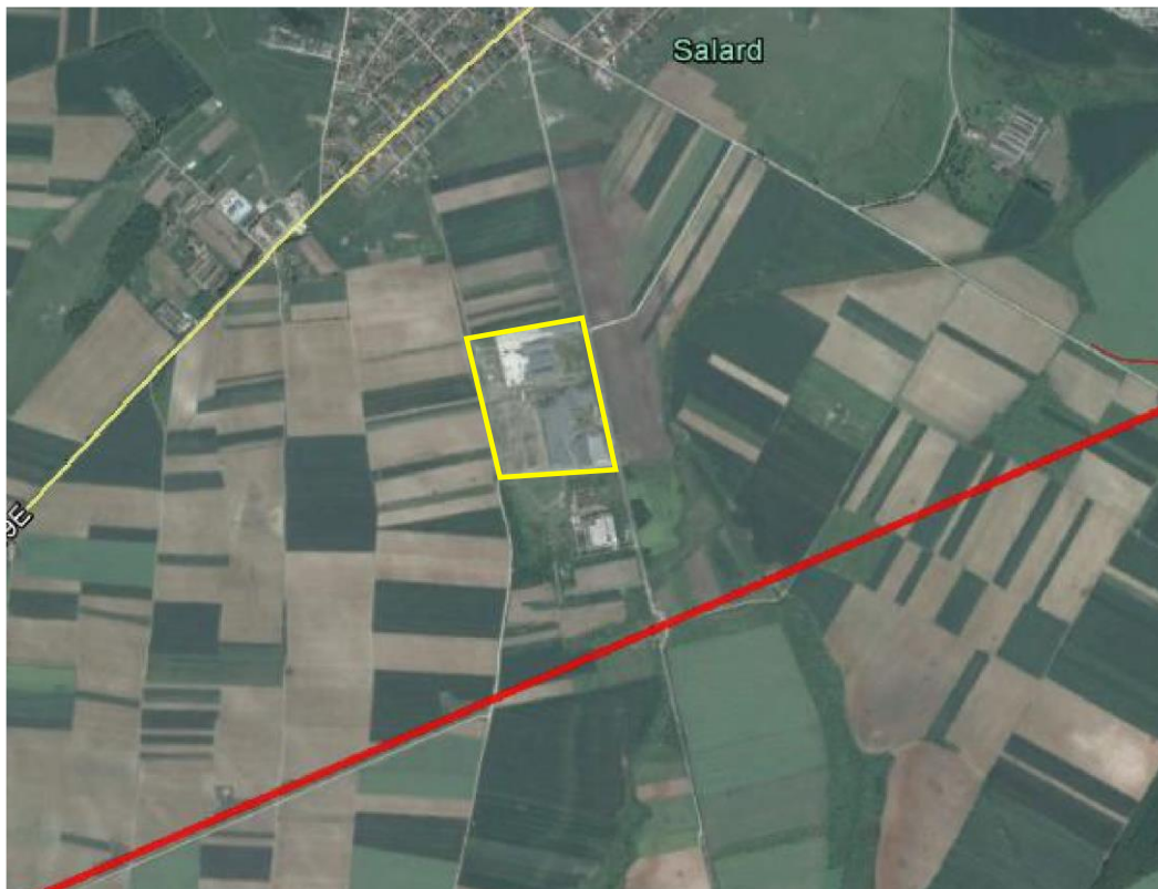
Fig.1.XVII. Organizarea de şantier Sălard (perimetru galben). Se observă situarea acestui obiectiv în imediata proximitate a Autostrăzii Braşov-Oradea, sector Ogra-Borş (linie roşie)
