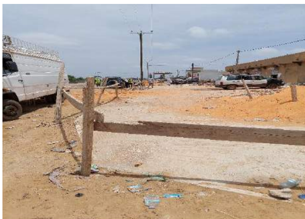
Photo 1 : Vue d'une extension de place d'affaires (devanture dallée) impactée au niveau de l'emprise AEP – Source I FALL, Novembre – décembre 2021
