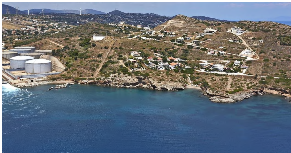
Φωτο 2. Άποψη από τη θάλασσα της περιοχής των έργων στην περιοχή Λαυρίου.
