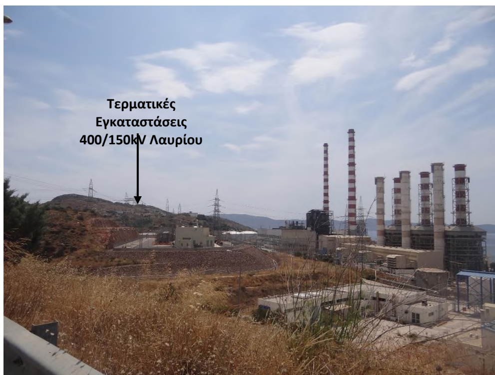
Φωτο 1. Τερματικές Εγκαταστάσεις 400/150kV Λαυρίου και ΑΗΣ Λαυρίου
