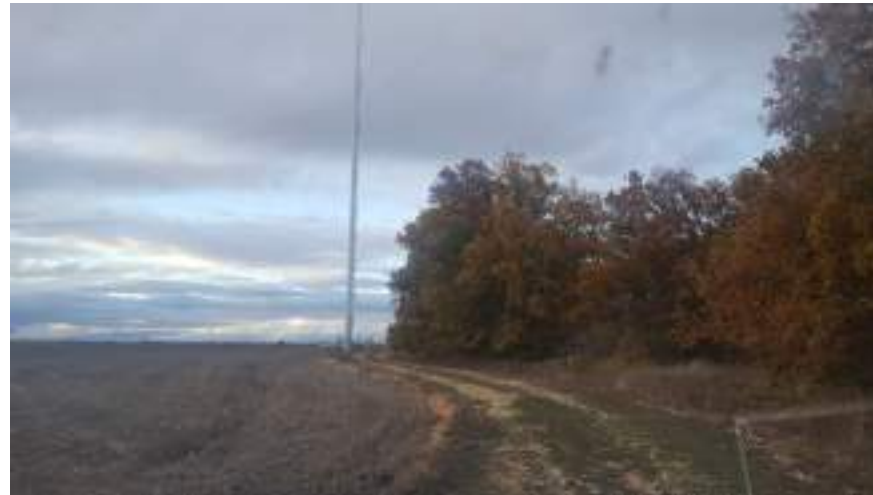
Foto 65: Vista de torre desde Punto 16.
