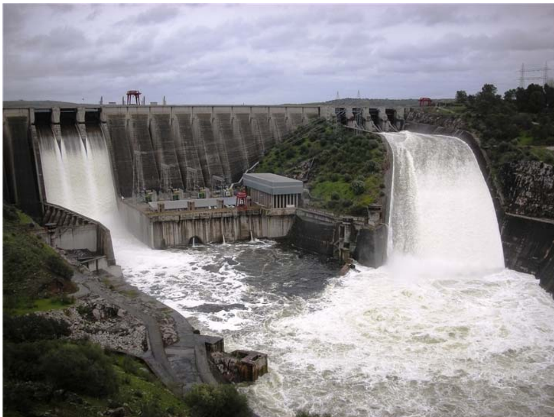
Ilustración 9: Central hidroeléctrica de Alcántara
