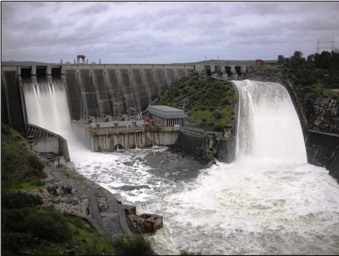
Ilustración 2: Central hidroeléctrica de Alcántara
