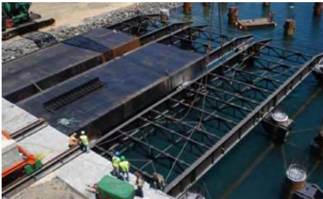
Figura 33 – Exemplo de montagem de cimbra móvel
