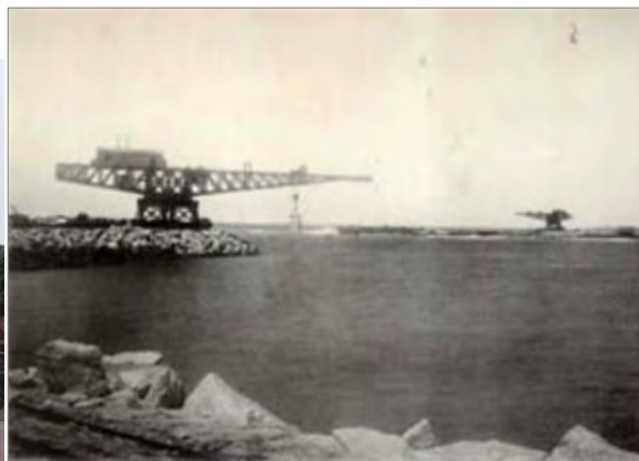
Figura 171 – Titãs durante a construção do porto de Leixões
