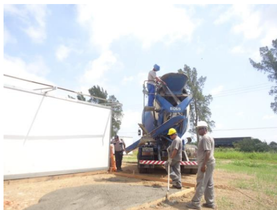
Figura 14. Resíduo depositado sobre piso sendo concretado.
