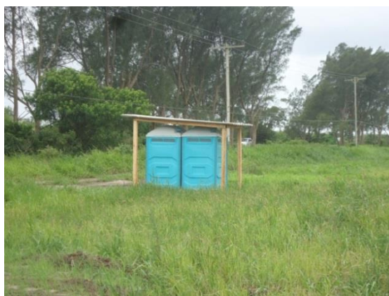
Figura 12. Exemplo de banheiro químico instalado em local sem sistema de efluentes.
