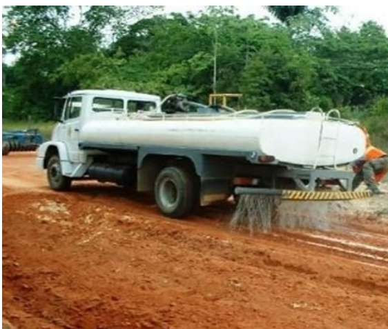
Caminhão realizando umectação da via
