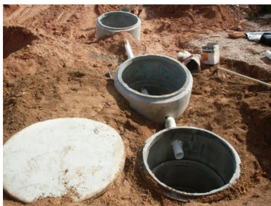
Figura 11. Exemplo de sistema de fossa em concreto.
