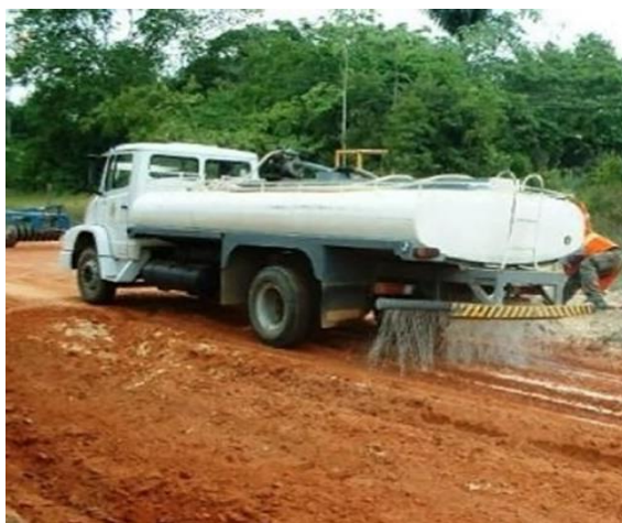
Figura 1. Umectação de acessos para evitar suspensão de poeira.
