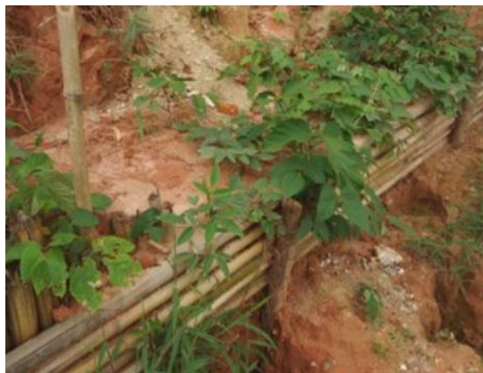
Figura 10. Exemplo de utilização de paliçadas, imagem meramente ilustrativa.
