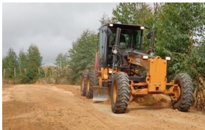
Figura 9. Motoniveladora espalhando solo, imagem meramente ilustrativa.
