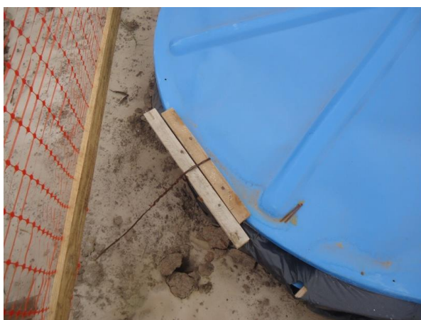
Figura 74. Exemplo de caixa d'água instalada como reservatório de efluentes com tranca em arame e madeira para vedar a tampa da caixa.
