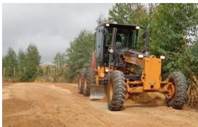
Figura 89. Motoniveladora espalhando solo, imagem meramente ilustrativa.
