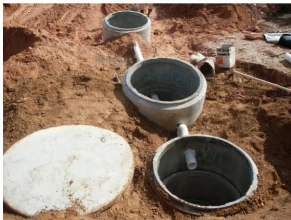
Figura 76. Exemplo de sistema de fossa em concreto.
