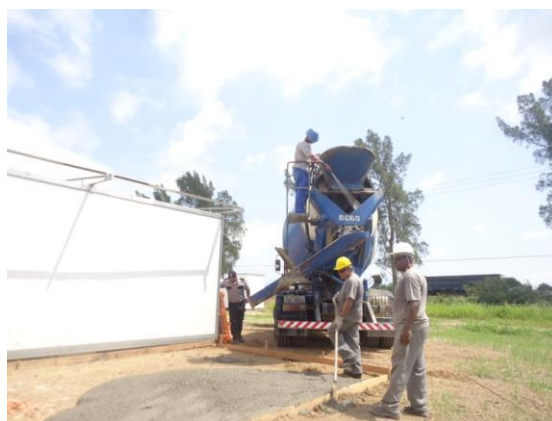
Figura 79. Resíduo depositado sobre piso sendo concretado.
