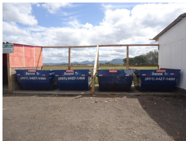
Figura 70. Estrutura da central de resíduos: Caçambas para resíduos da construção civil (RCC). Imagem meramente ilustrativa.
