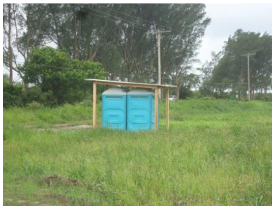
Figura 77. Exemplo de banheiro químico instalado em local sem sistema de efluentes.
