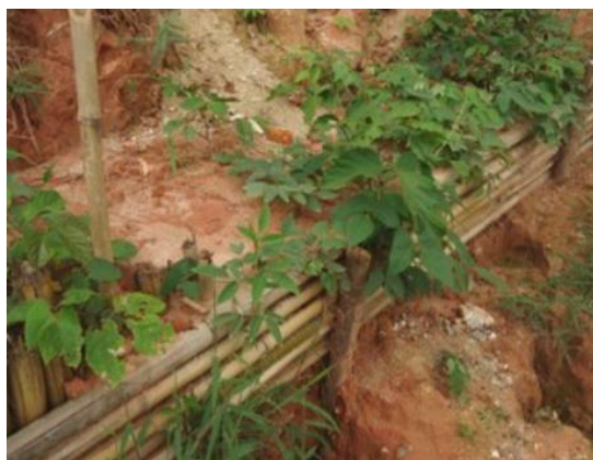
Figura 91. Exemplo de utilização de paliçadas, imagem meramente ilustrativa.
