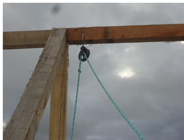
Figura 68. Detalhe da roldana presa em uma estrutura de madeira. Imagem meramente ilustrativa.
