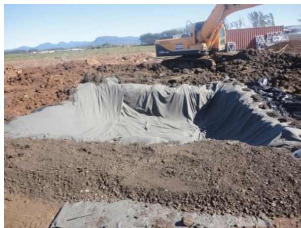
Figura 82. Exemplo de tanque de sedimentação com rampa com geotêxtil.
