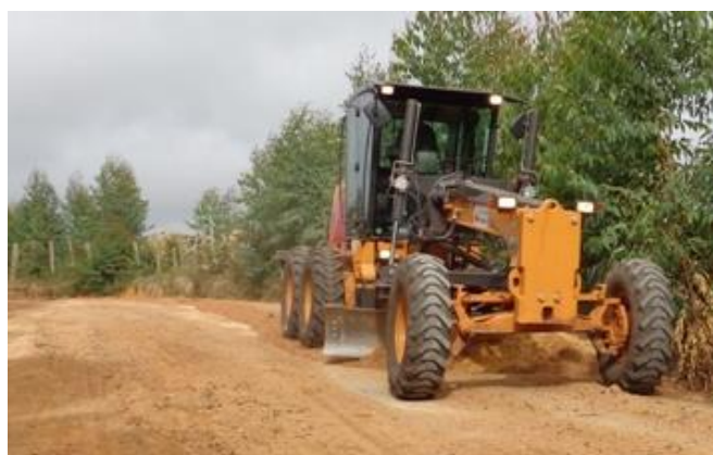
Figura 89. Motoniveladora espalhando solo, imagem meramente ilustrativa.
