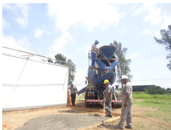
Figura 79. Resíduo depositado sobre piso sendo concretado.
