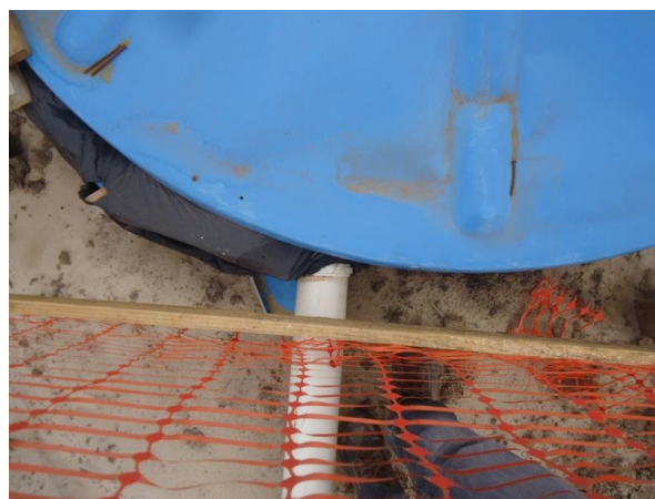
Figura 73. Detalhe do cano coletor vedado.
