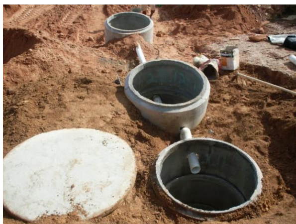
Figura 76. Exemplo de sistema de fossa em concreto.
