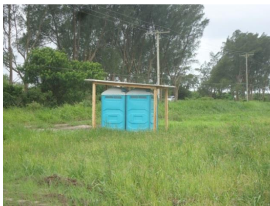
Figura 77. Exemplo de banheiro químico instalado em local sem sistema de efluentes.
