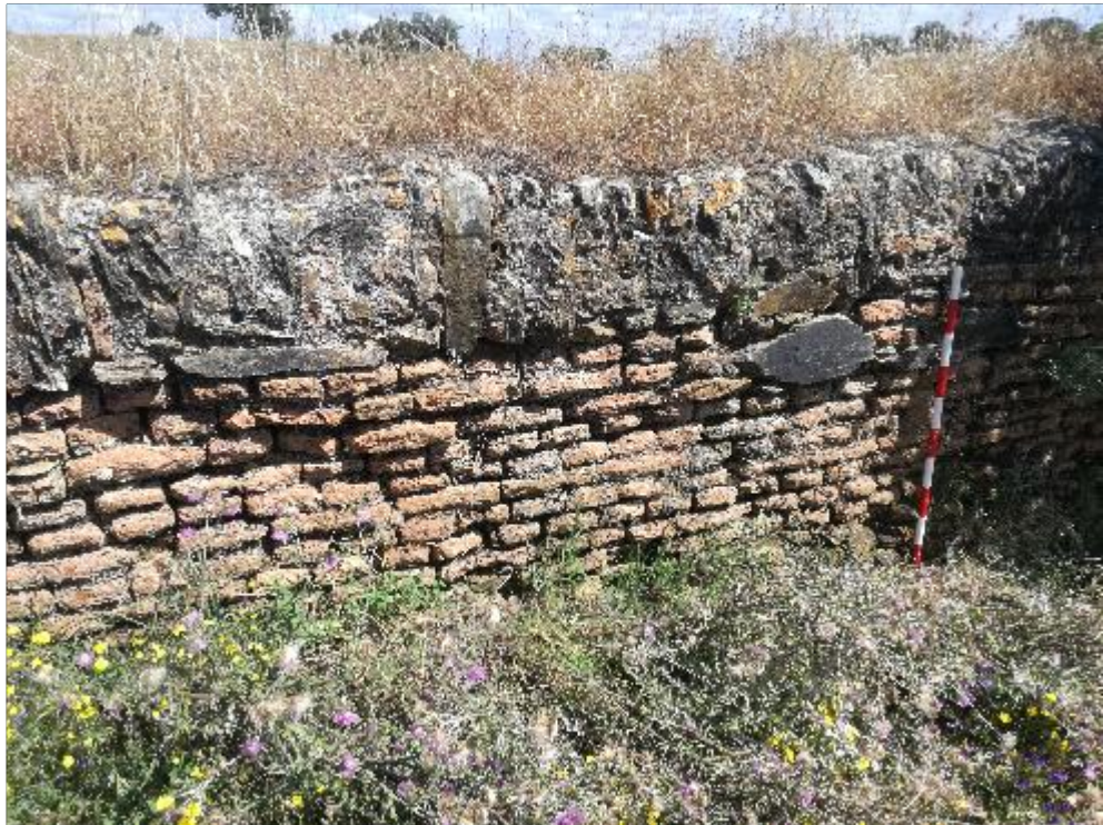
Cara interior de la presa
