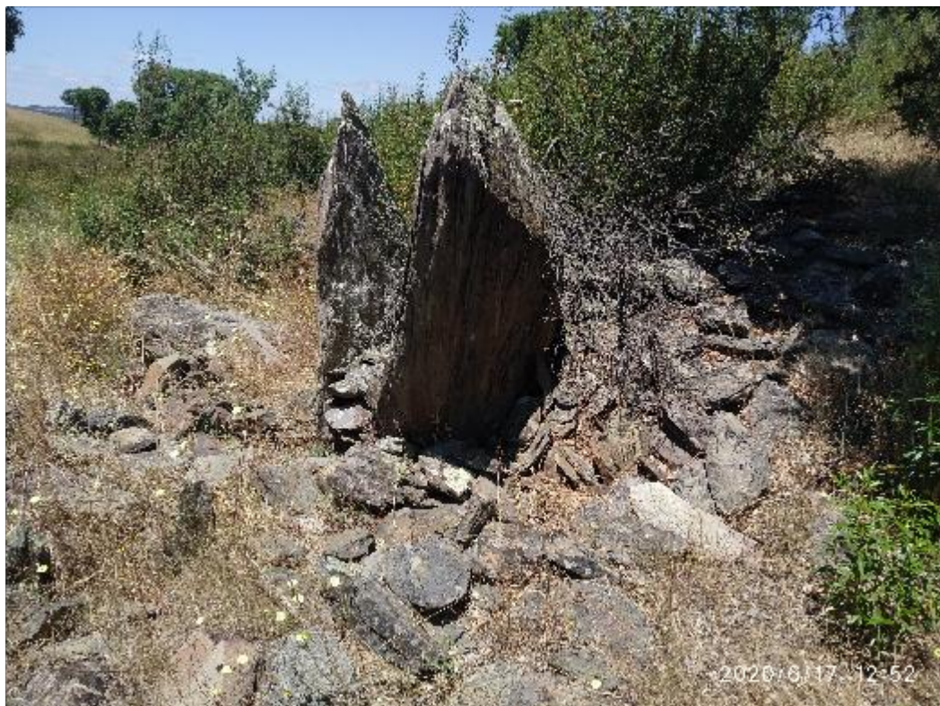
Falla de pizarra aprovechada como parte del murete que cerraría el patio
