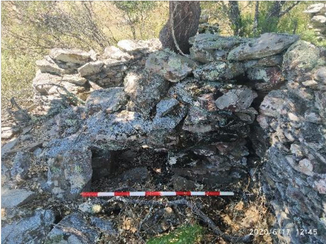
Detalle de uno de los pequeños vanos que permitirían salir al patio
