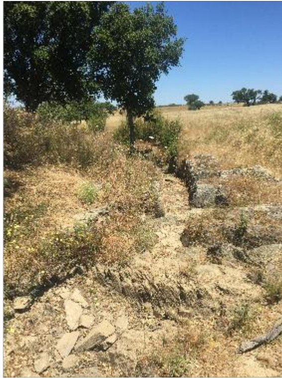
Aliviadero canalizado excavado en la roca
