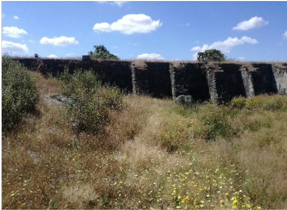
Cara exterior de la presa con los cinco contrafuertes
