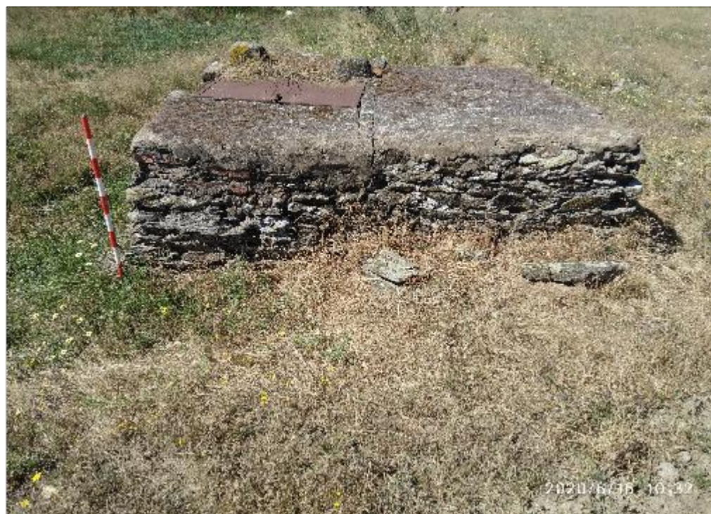
Vistas del pozo. Se observa bien el abrevadero y su cubierta moderna
