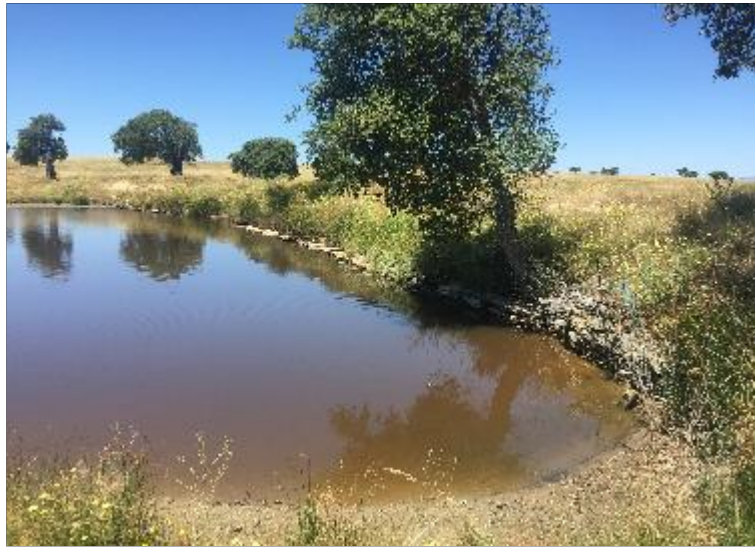
Muro de contención en el lado de mayor desnivel
