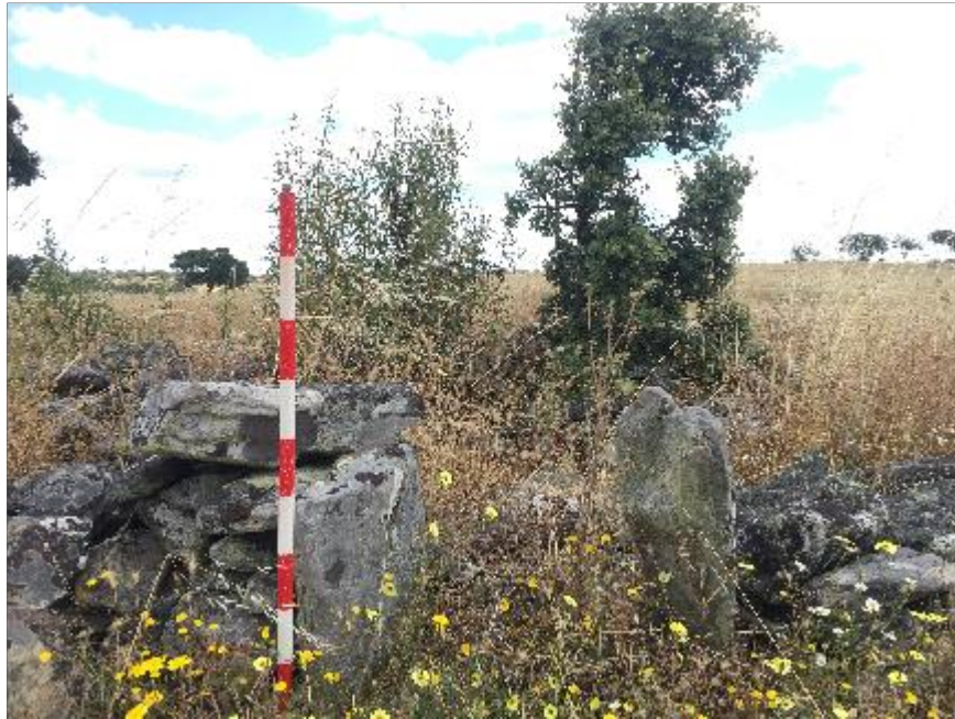
Foto de detalle de una posible entrada, se observa su estado actual ruinoso
