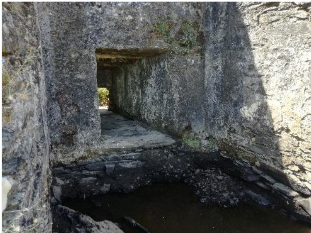
Detalle del aliviadero practicado en la presa
