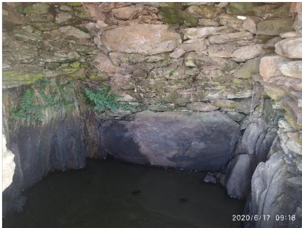
Vista del interior del pozo excavado en una falla de pizarra y con paredes también de pizarra
