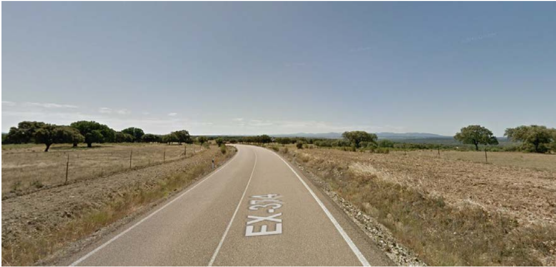
Ilustración 6. Posición 5 del tramo de la carretera
