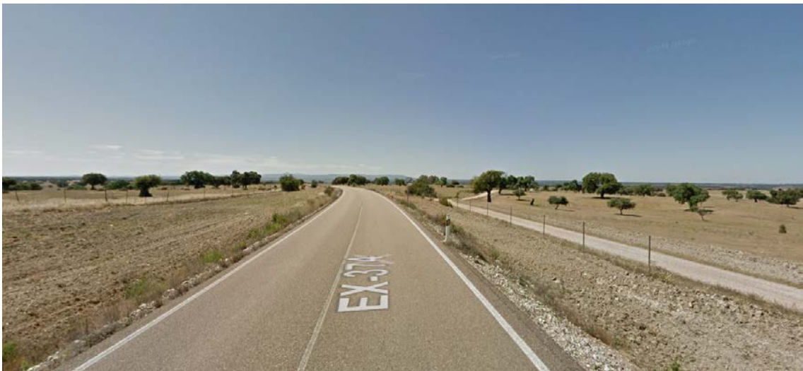
Ilustración 5. Posición 4 del tramo de la carretera
