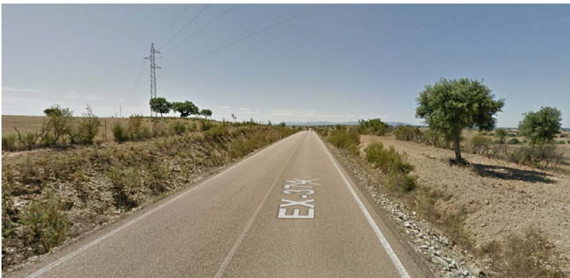
Ilustración 3. Posición 2 del tramo de la carretera
