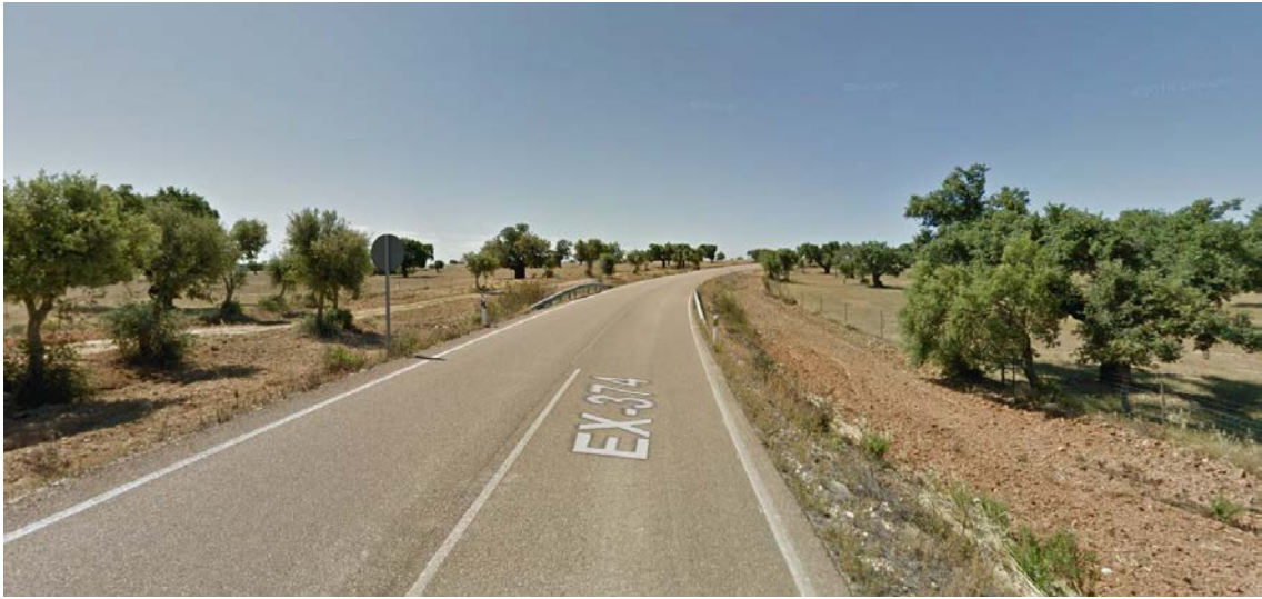
Ilustración 4. Posición 3 del tramo de la carretera
