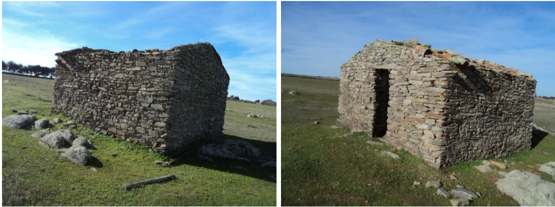
Figura 11 y 12: Presencia de algunos elementos de época contemporánea: casa de planta cuadrangular que en su tiempo estuvo techada a dos aguas con teja árabe sobre vigas de madera, y que actualmente se halla hundido.
