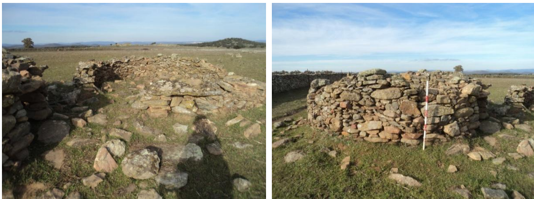
Figura 33 y 34: dos zahúrdas de mampostería de pizarra y cuarcita, ambas de unos 3 metros de diámetro y unos 50 cm de grosor de muro. La de la izquierda conserva un alto máximo de 1.30 metros y una pequeña puerta de apenas 40 cm de alto, mientras el de la derecha está peor
