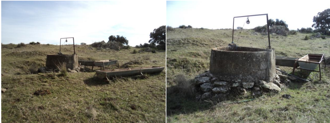
Figura 25 y 26: Parcela contigua a la Parcela 80 del polígono 4: pozo de brocal de ladrillo contemporáneo lucido de cemento
