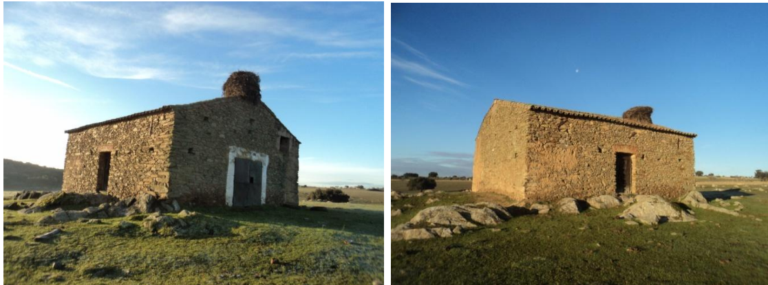
Figura 49 y 50: casa de labor contemporánea construida con mampostería de lajas de pizarra y restaurada para la labor agrícola.
