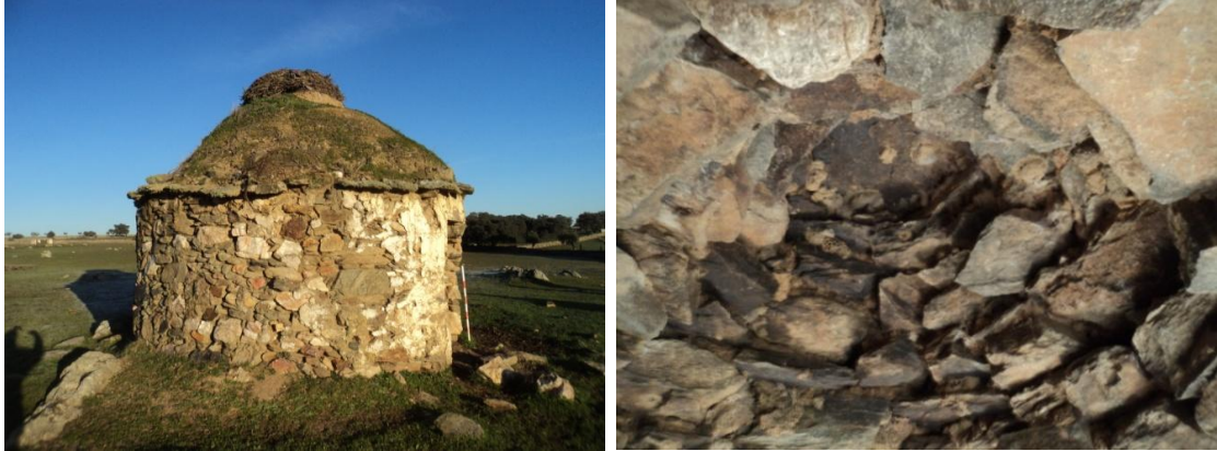
Figura 53 y 54: Chozo construido en mampostería de pizarra cuarzo y cuarcita, de planta circular con muros de 50 cm de grosor, la puerta tiene 1.60 metros de alto por 80 cm ancho, la cubierta está formada por una bóveda de aproximación de hiladas de pizarra y presenta enlucido de cal y arena. El alto total del chozo es de 3.50 metros y un diámetro de 3 metros y en su interior presenta pequeños vanos a modo alacena (3 alacenas y una ventana). Sus coordenadas son: UTM: 29N 714605/4226547.
