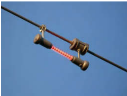
Ilustración 1: Señalización luminosa sobre conductor
