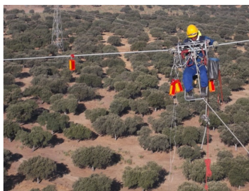
Foto 3 Señalización con aspapas en cable de tierra
