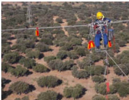
Ilustración 2: Señalización luminiscente en cable de tierra
