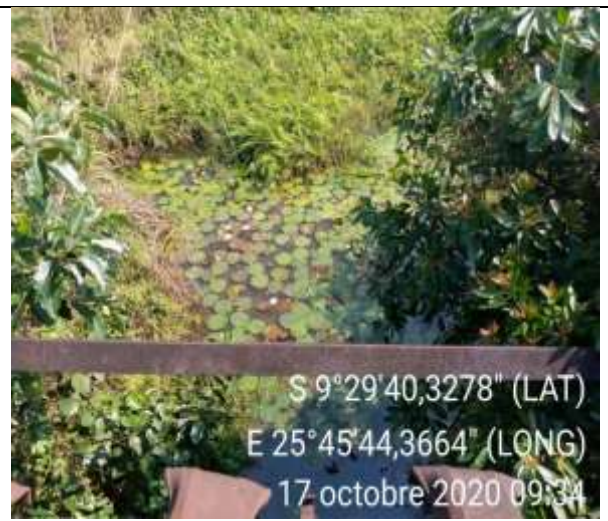
Photo. Pont Lububu 13,22 m
