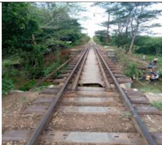
Photo . Le Pont Kamoia de 15 m
