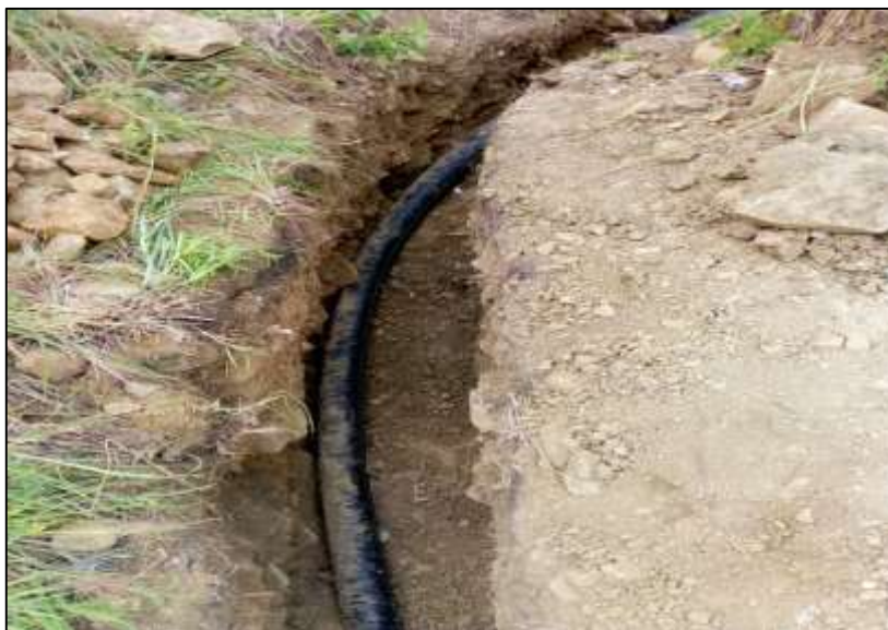
Photo 2. Installation du conduit (HDP)
