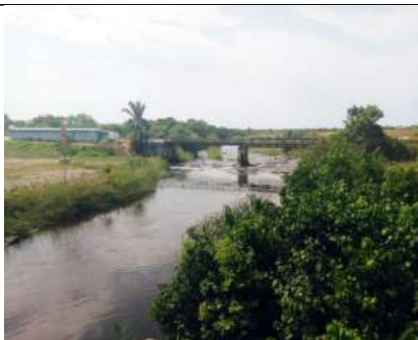
Photo . Pont Luao de 40 m qui relie l'Angola et la RDC (Territoire de Dilolo)
