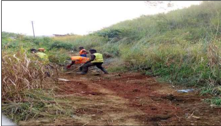
Photo 3. Remblayage Tranchée
