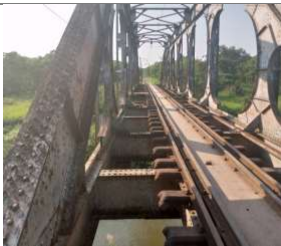
Photo . Le Pont Iufupa de 40 m
