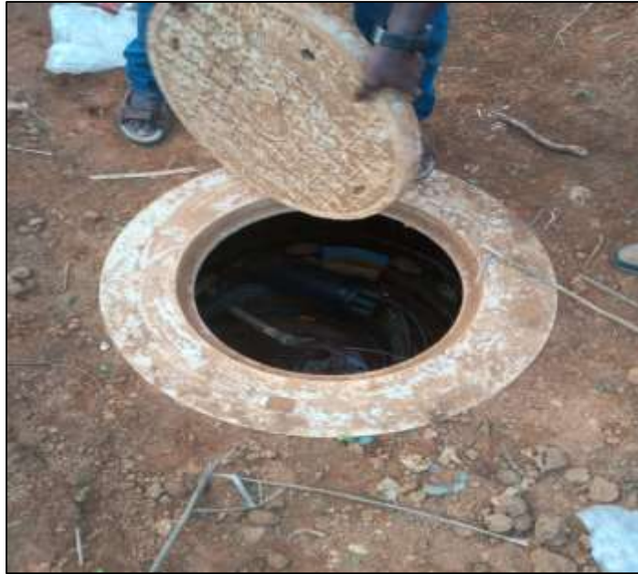
Photo 5. Installation du regard
