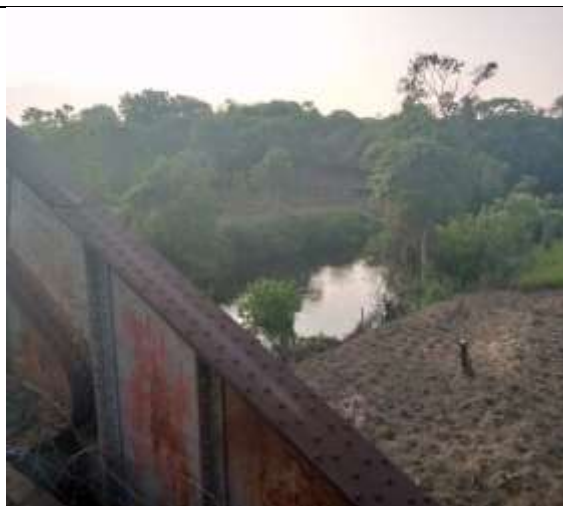
Photo. Pont Kalo de 50 m
