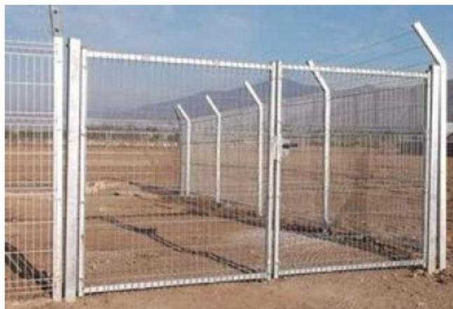
Figura 1.4.9.a. Detalle de portón de dos hojas batientes tipo Acmafor.
