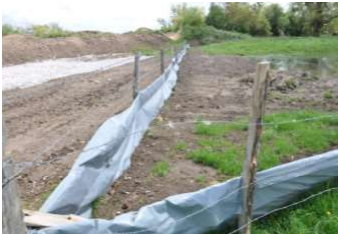
Photographies 28 et 29 : exemple de barrière à mettre en place pour éviter la fréquentation des tritons du site d'implantation de la centrale photovoltaïque en phase travaux
