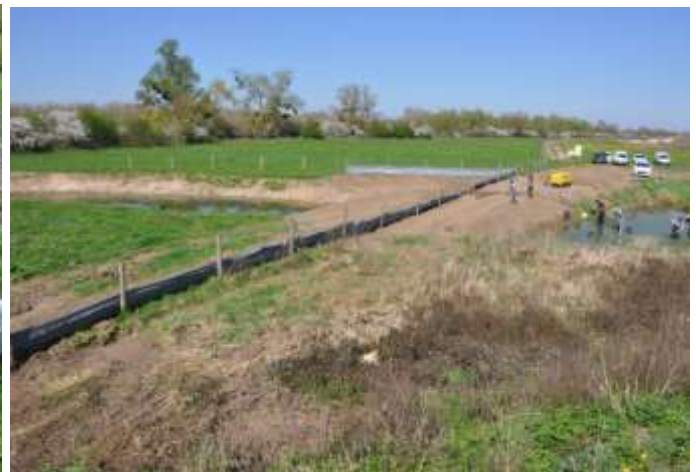
Photographies 28 et 29 : exemple de barrière à mettre en place pour éviter la fréquentation des tritons du site d'implantation de la centrale photovoltaïque en phase travaux
