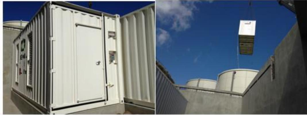
**Figure 11 : Containers TESLA accueillant les batteries de stockage (1) (Source : Rapport de présentation du projet d'ALBIOMA, Décembre 2019)**
