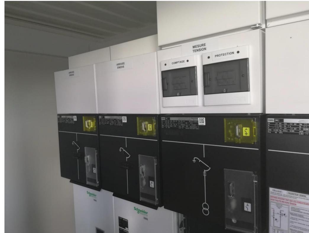
**Figure 13 : Container de conversion d'énergie comprenant l'électronique de puissance et le poste HTA (Source : Rapport de présentation du projet d'ALBIOMA, Décembre 2019)**
