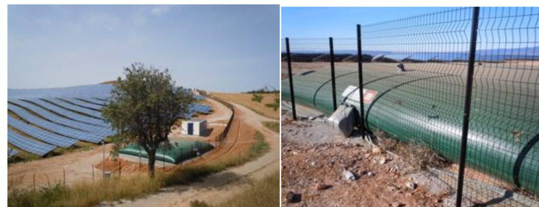
**Photographies 14 et 15 : Citerne à incendie présente au sein de parcs photovoltaïques déjà en exploitation sur le plateau Puimichel de même type que celle prévue au sein de la CPES La Plaine des Mées**
