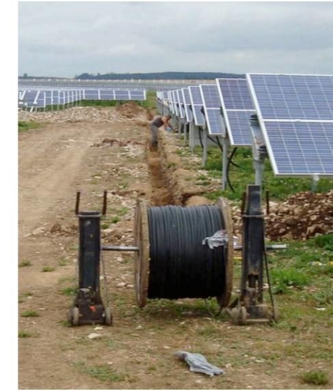
Figure 24 : Creusement des tranchées et passage des câbles électriques (Source : GP Joule GmbH)
