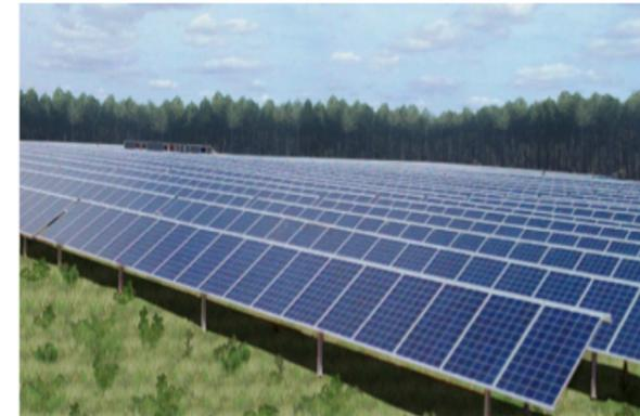
Les modules photovoltaïques transforment la lumière du soleil directement en électricité sans aucun mouvement, bruit ou apport de matière supplémentaire (carburant, eau, ...)
