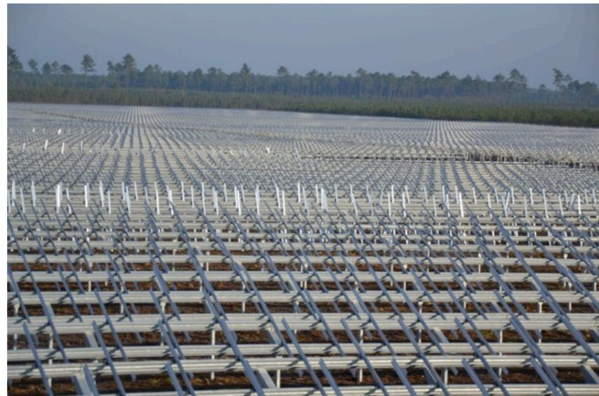
Figure 23 : Fixation des pieds et des systèmes de support (Source : GP Joule GmbH)
