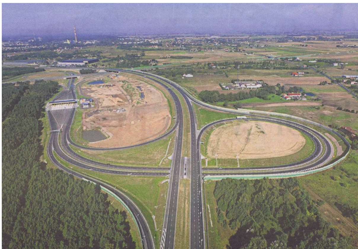
Rys. 8 Przekształcenia powierzchni ziemi w rejonie węzłów drogowych (przykład)
